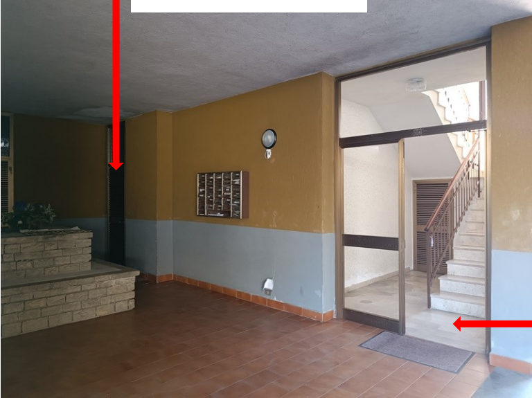
PORTA ACCESSO CANTINE
