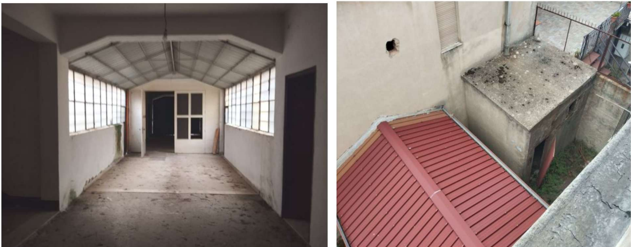
Figg. 5- 6 - Porzione con superfici vetrate e copertura in lamiera
