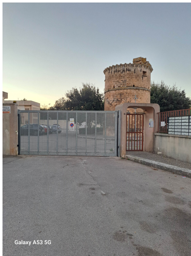
FOTO 1 Via Mario di Lecce 14 – ingresso al complesso edilizio La Torre
