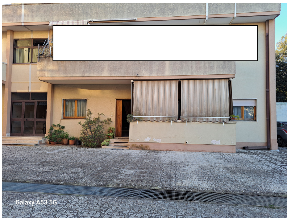
FOTO 2 Ingresso abitazione Piano Rialzato Fabbricato 1B (sub. 33)
