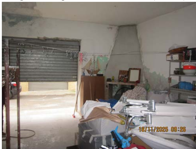
Magazzino al piano terra Via Alfieri (cantina)
