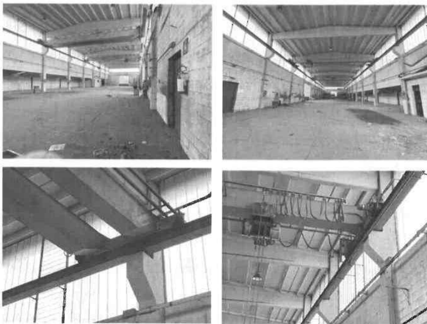
Figura 6 - Capannone, interni e carroponeti
