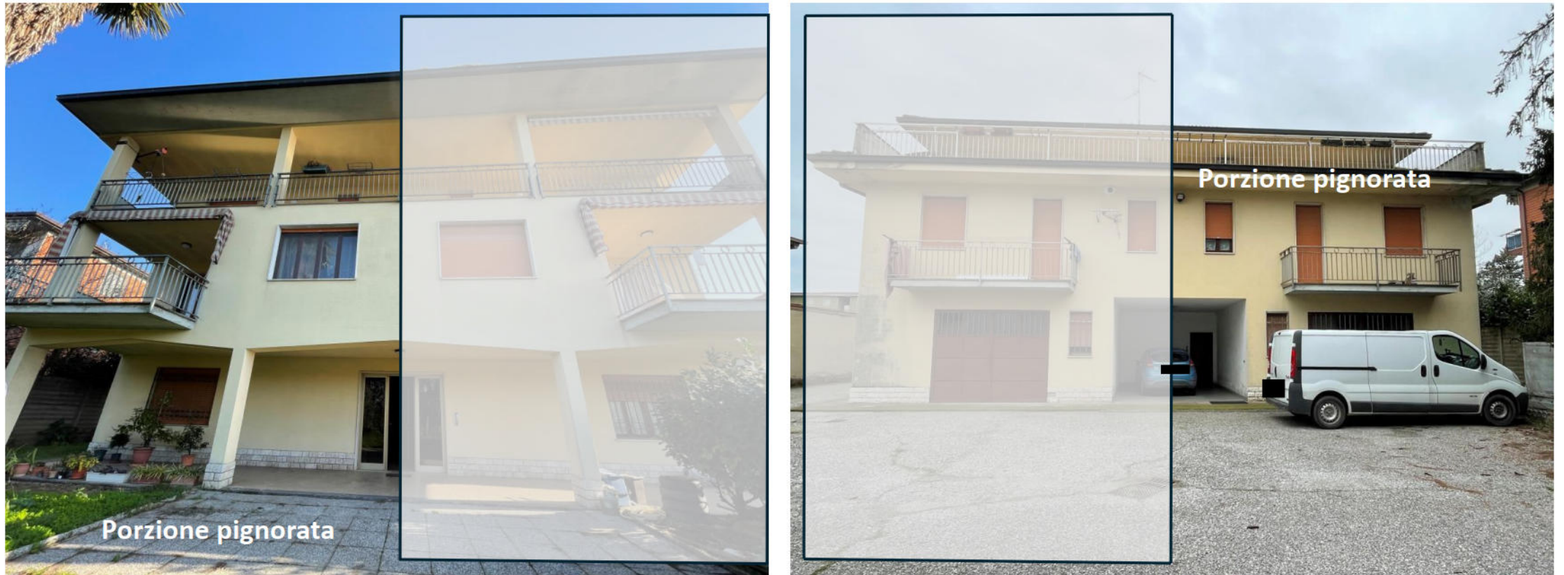
Fronte e retro palazzina
