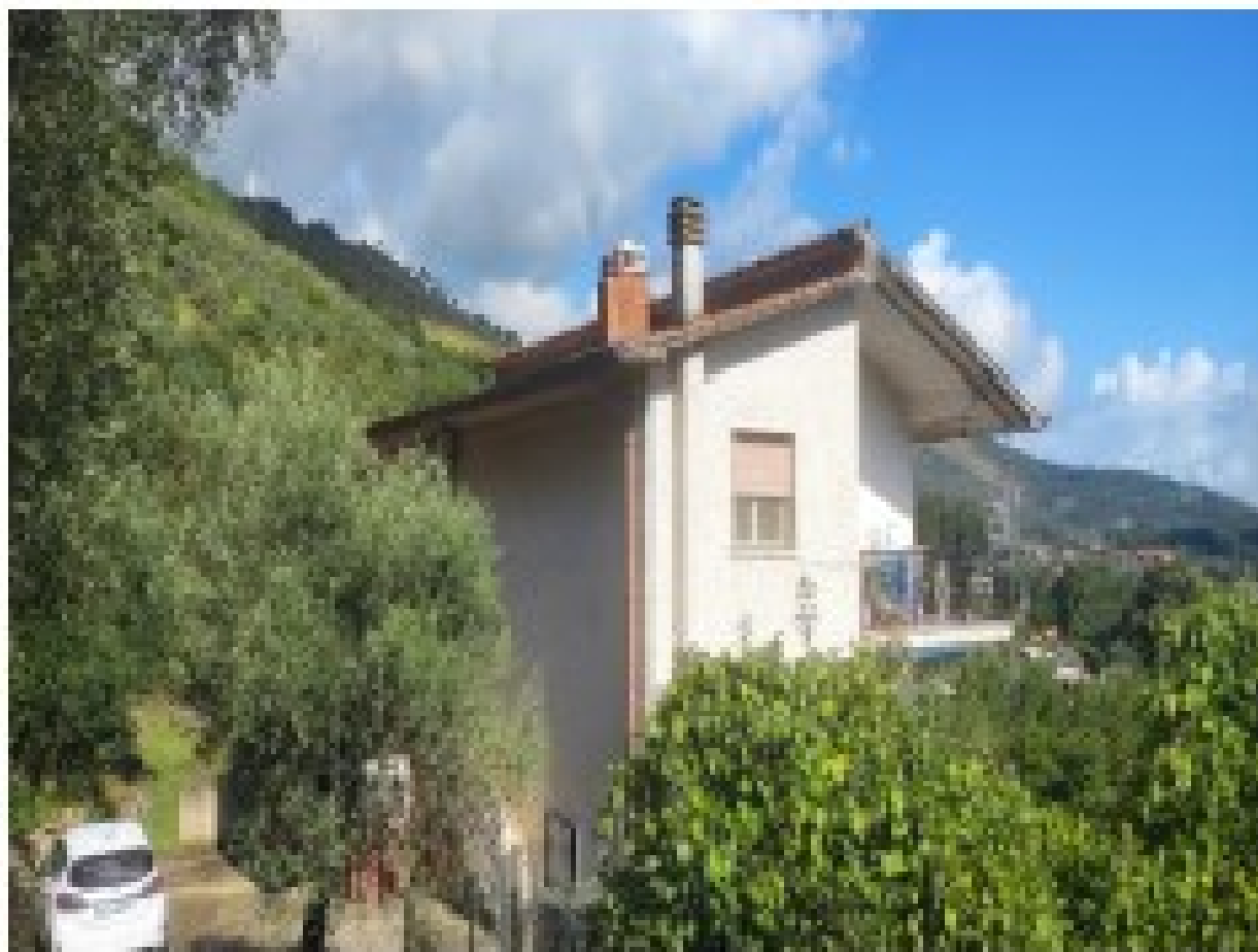
COMUNE DI PROSEDI IN STRADA MONTI LEPINI 156 KM 20.100, F 9 P 261 SUB 7
