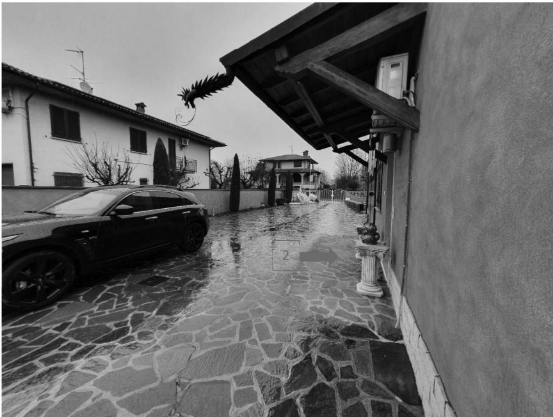
FOTOGRAFIA 4: Vista dell'ingresso carrabile e del cortile – lato nord e vista ingresso (2).
