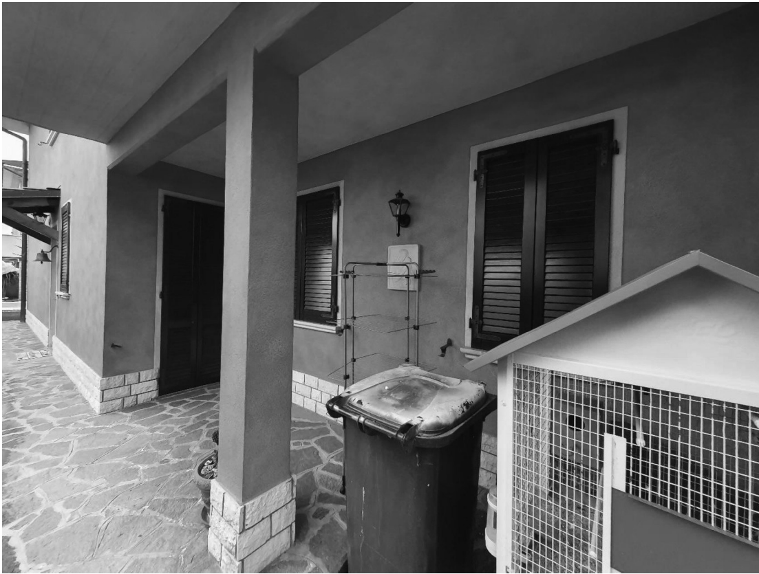
FOTOGRAFIA 8: Vista del portico posto a piano terra – lato sud.
