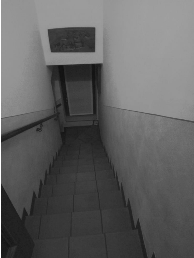
FOTOGRAFIA 27: Vista del vano scala.
