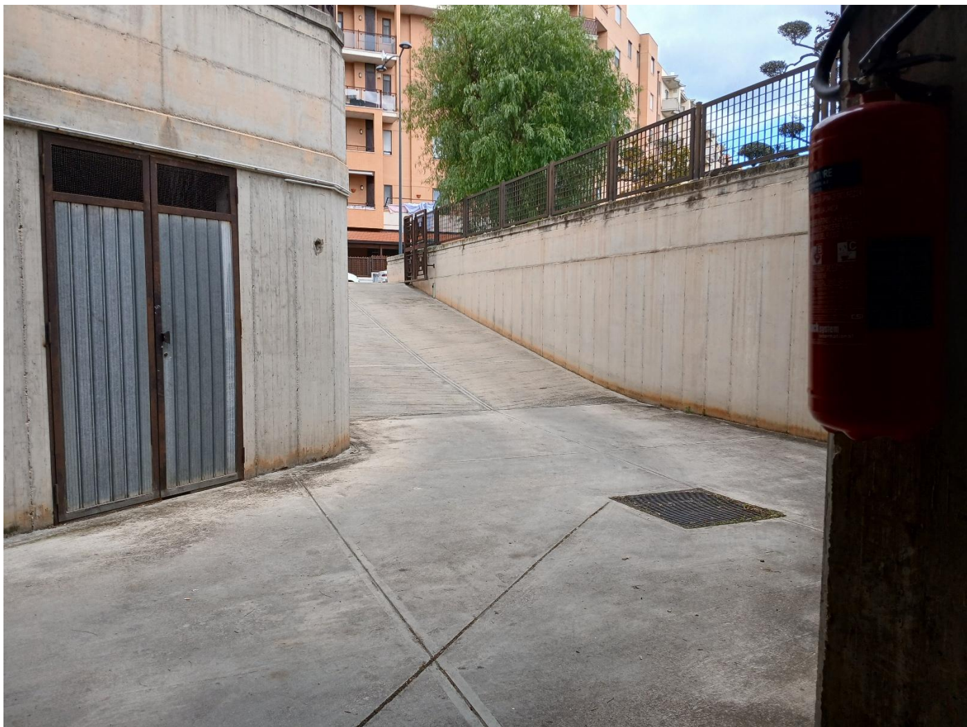
RAMPA DI ACCESSO AL BOX AUTO
