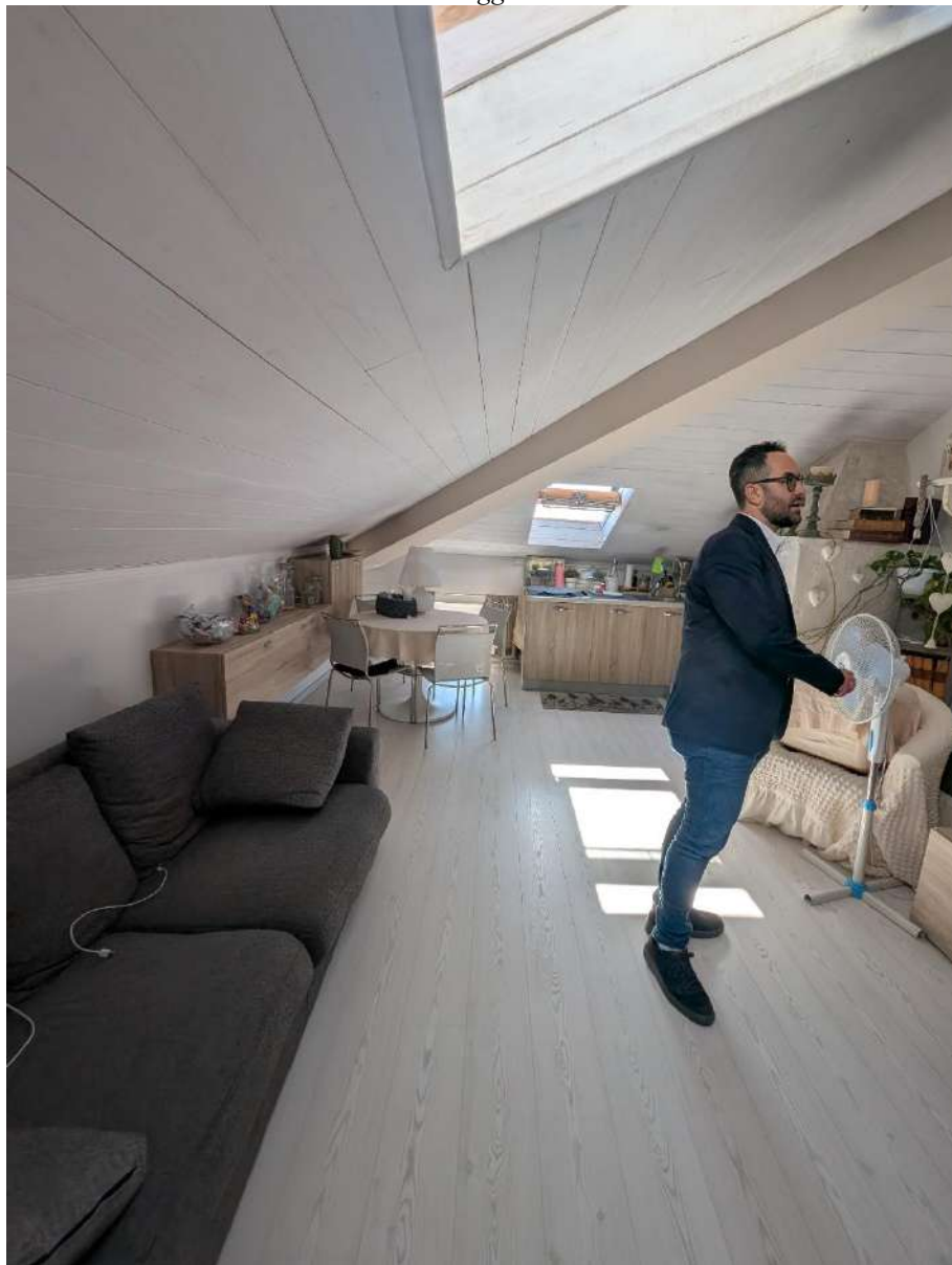
FOTO N° 41/42 – vano adibito abusivamente a Soggiorno/cucina
