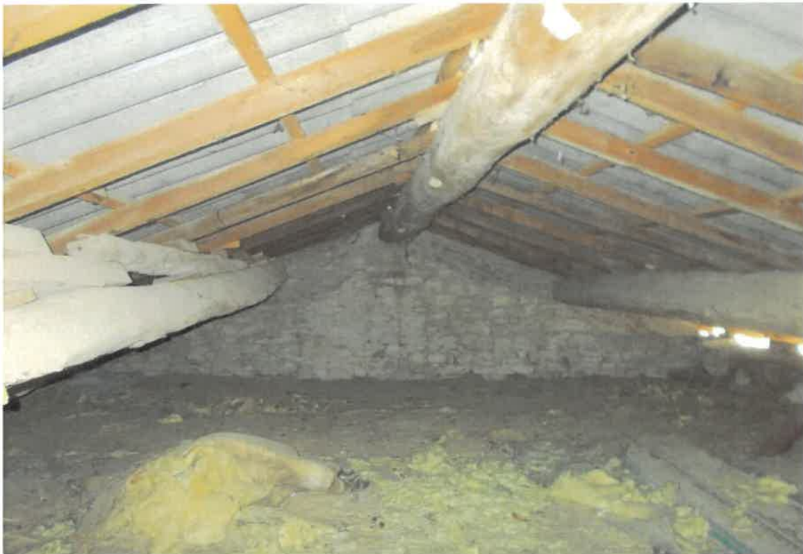
14. Particolare interno – locale sottotetto
