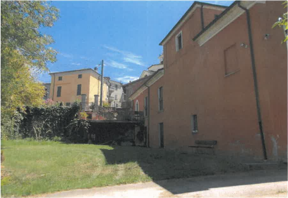
3. Fabbricato ad uso civile abitazione con antistante sedime cortilizio – prospetto nord
