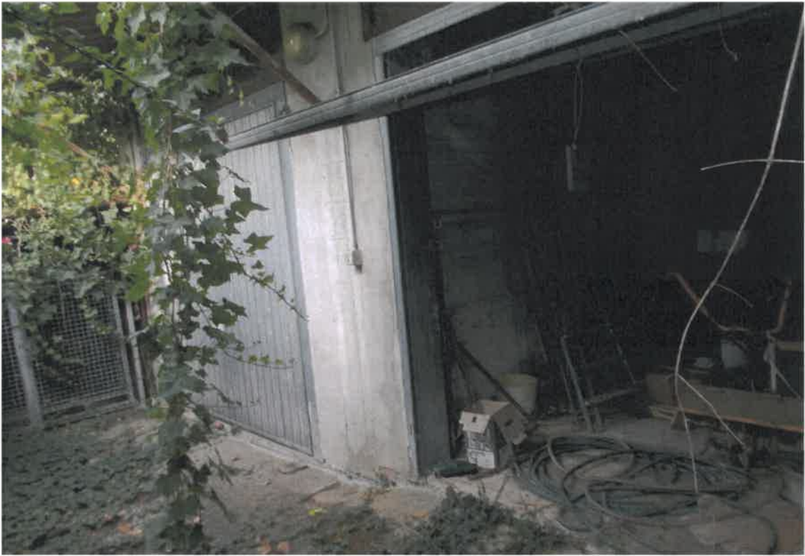
7. Locali di deposito sottostante il portico - oggetto di demolizione
