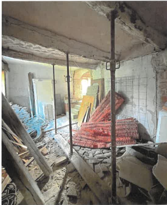
13. Particolare interno – locali al piano seminterrato
