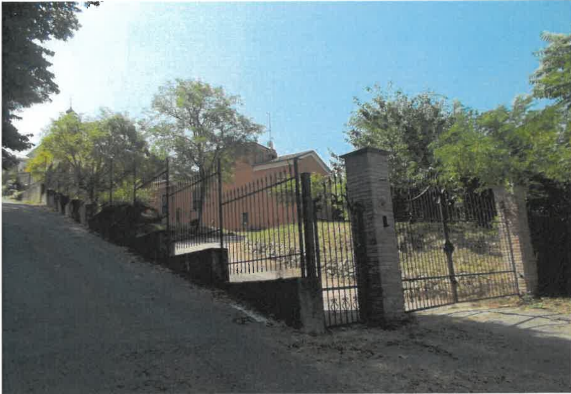
1. Particolare accesso carraio al fabbricato - oggetto della presente esecuzione immobiliare
