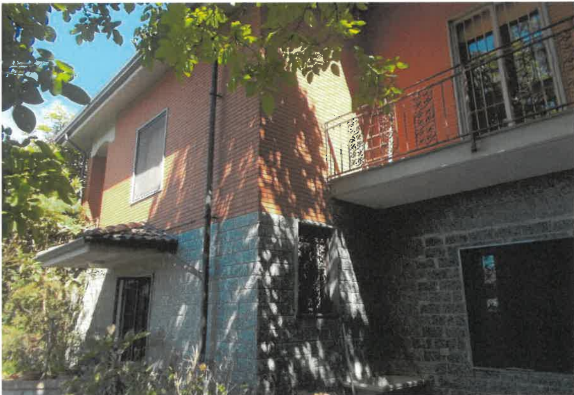
2. Villetta ad uso civile abitazione - particolare prospetto nord-est
