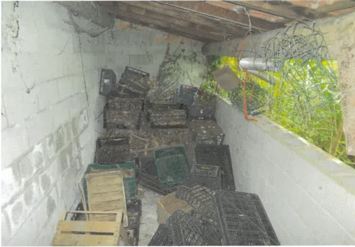
5. Tettoia aperta sottostante il portico - oggetto di demolizione
