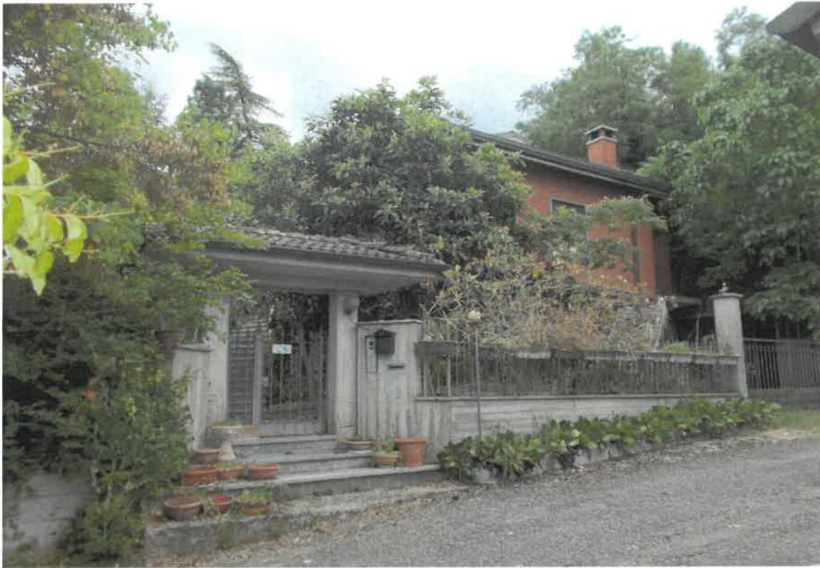
1. Villetta ad uso civile abitazione - particolare accesso pedonale e carraio
