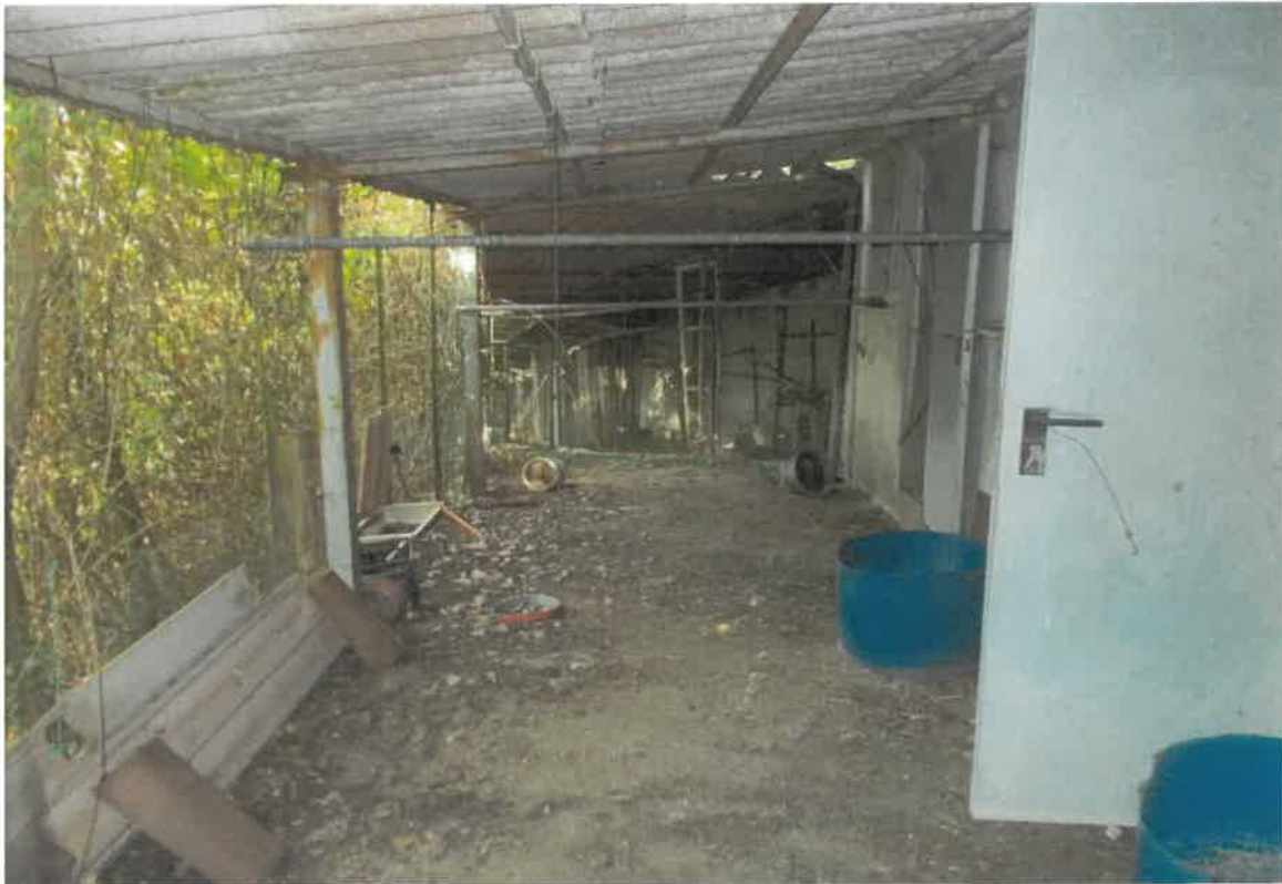
6. Locali di deposito sottostante il portico - oggetto di demolizione
