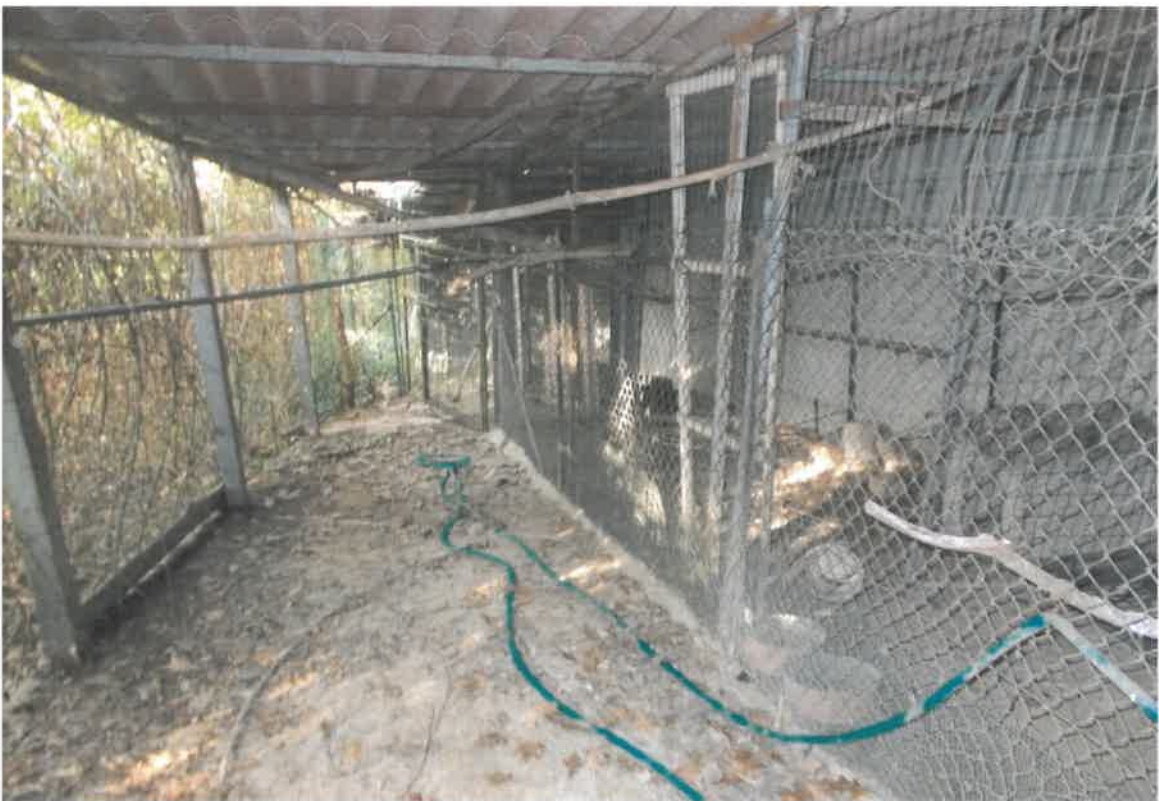
8. Locali di deposito sottostante il portico - oggetto di demolizione
