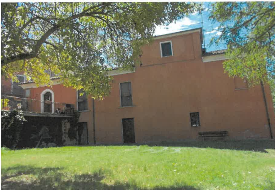
2. Fabbricato ad uso civile abitazione – prospetto nord
