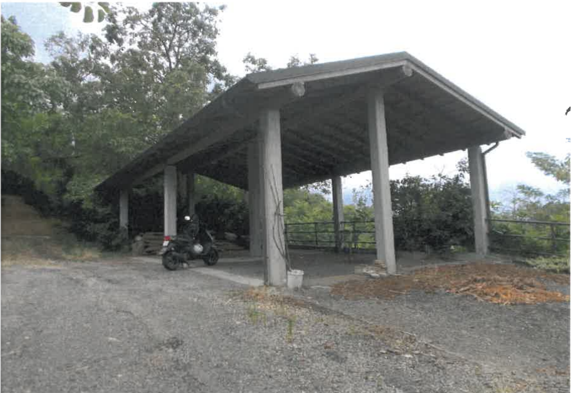
4. Porticato aperto - oggetto di demolizione
