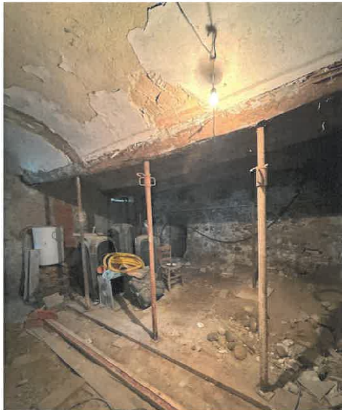
12. Particolare interno – locali al piano seminterrato
