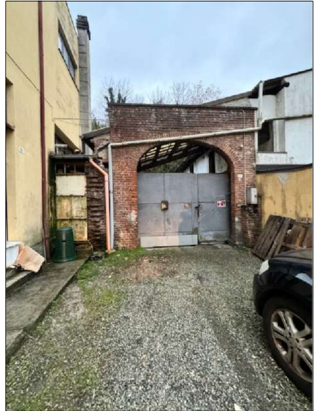
02 – Ingresso esterno su strada privata
