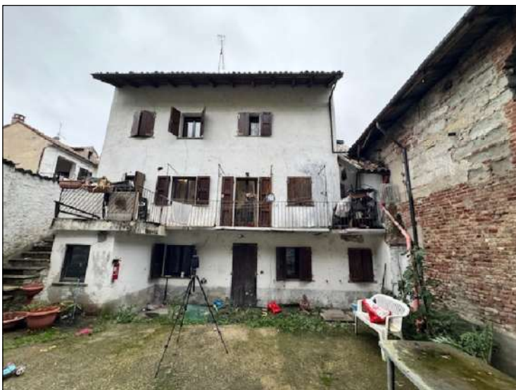
07 - Fronte su cortile interno
