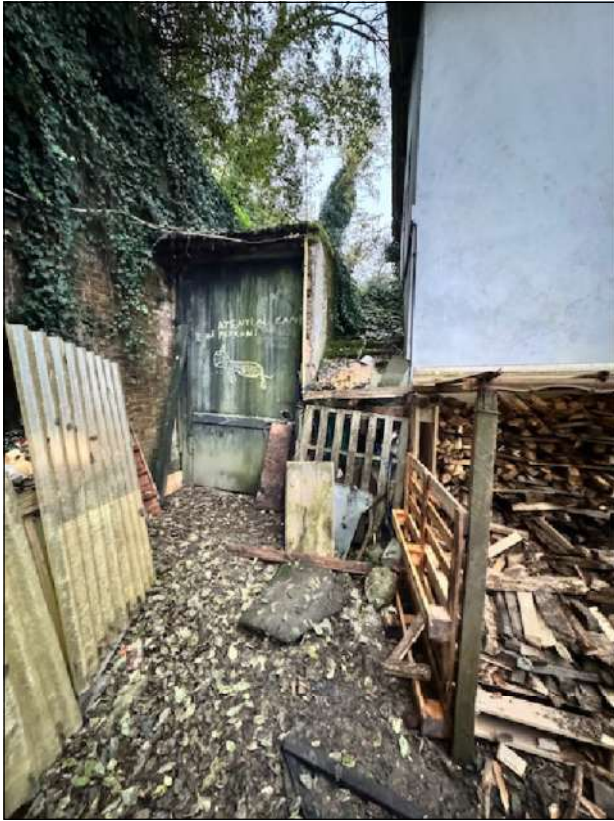
05 - Ingresso a androne/portico da cortile laterale
