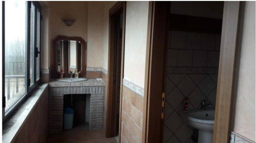
FOTO 8 –EDIFICIO B: BAGNI AL PIANO PRIMO
