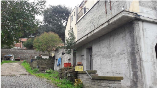
FOTO 13 –ALTRI MANUFATTI SUL LATO POSTERIORE
