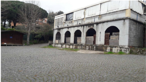
FOTO 9 -EDIFICIO B E BUNGALOW PREFABBRICATO
