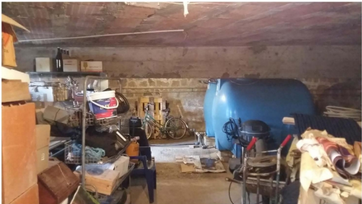
FOTO 12 -EDIFICIO A: CANTINA AL PIANO PRIMO
