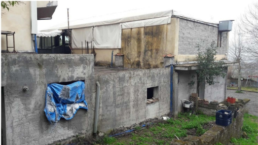
FOTO 14 –LATO POSTERIORE CON EDIFICIO B ED ALTRI MANUFATTI
