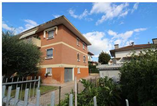
Foto 2: edificio condominiale prospetto laterale sud
