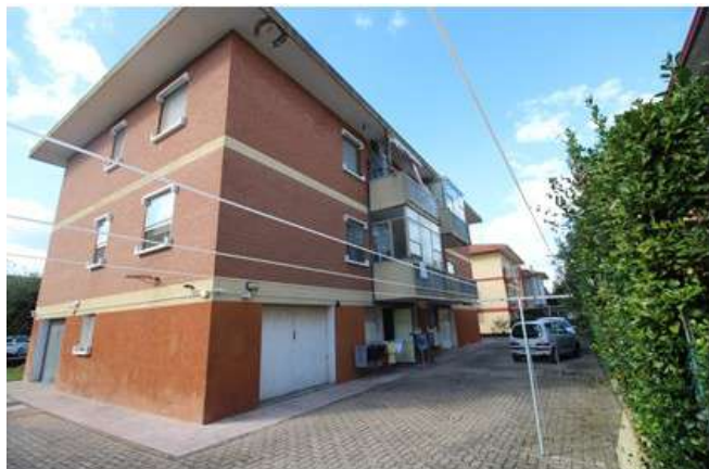
Foto 3: edificio condominiale – prospetto retro est
