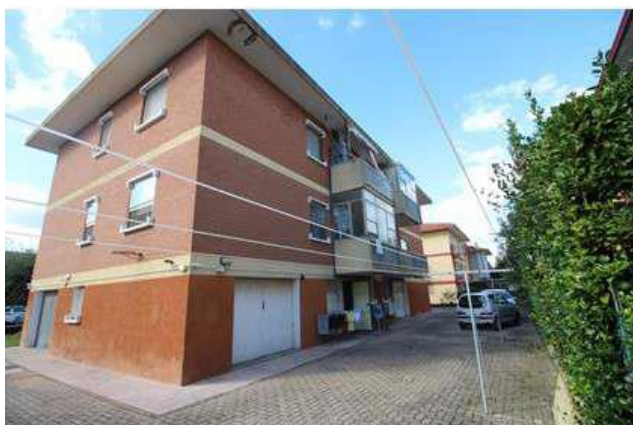
Foto 3: edificio condominiale – prospetto retro est
