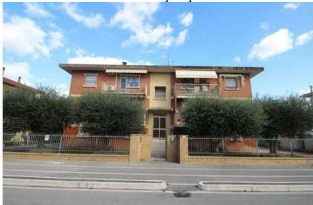
Foto 1: edificio condominiale – prospetto ovest su via Sozzi
