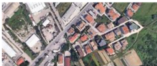
Inquadramento degli immobili pignorati;
