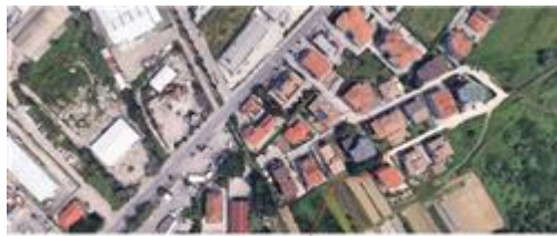
Inquadramento degli immobili pignorati;
