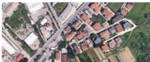
Inquadramento degli immobili pignorati;
