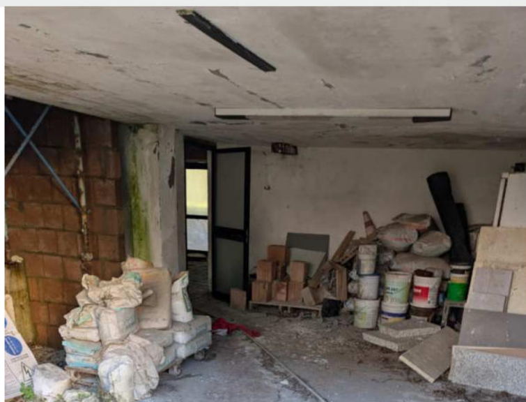
Foto n.3: veduta interna del locale ad uso autorimessa di pertinenza del villino;
