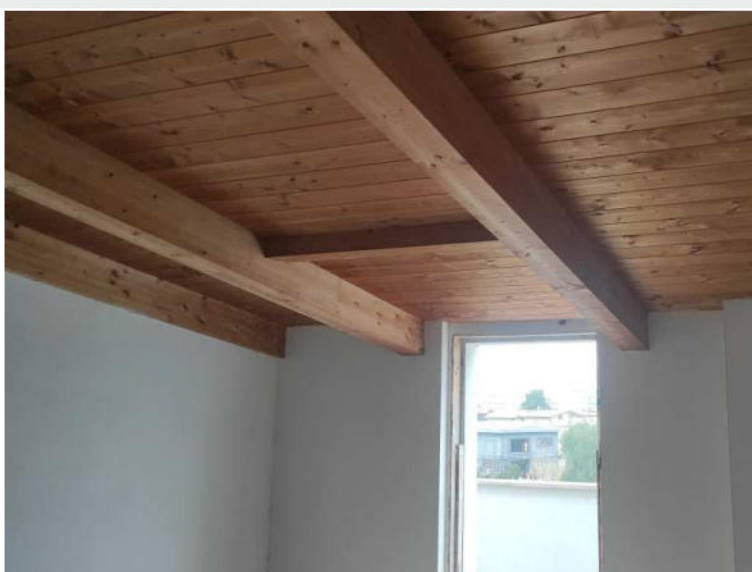
Foto n.74: veduta interna della camera da letto ubicata sul lato Sud-Ovest dell'appartamento;
