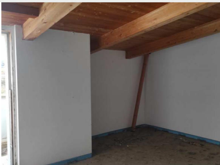
Foto n.73: veduta interna della camera da letto ubicata sul lato Nord-Est dell'appartamento;
