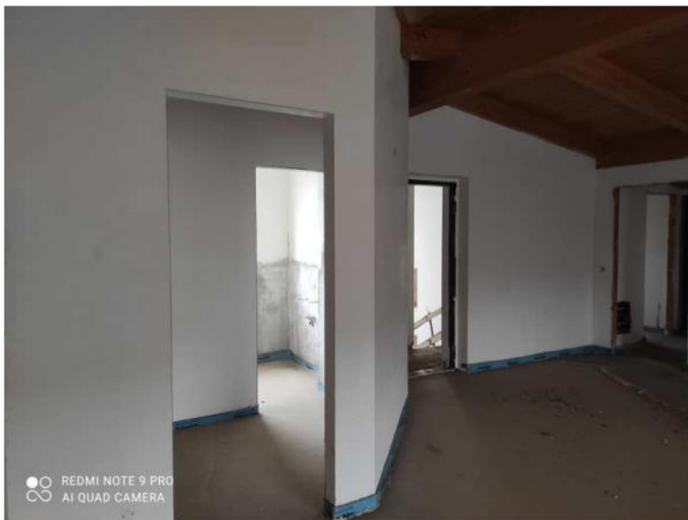
Foto n.72: ingresso al disimpegno del servizio igienico ubicato sul lato Nord-Ovest dell'appartamento;
