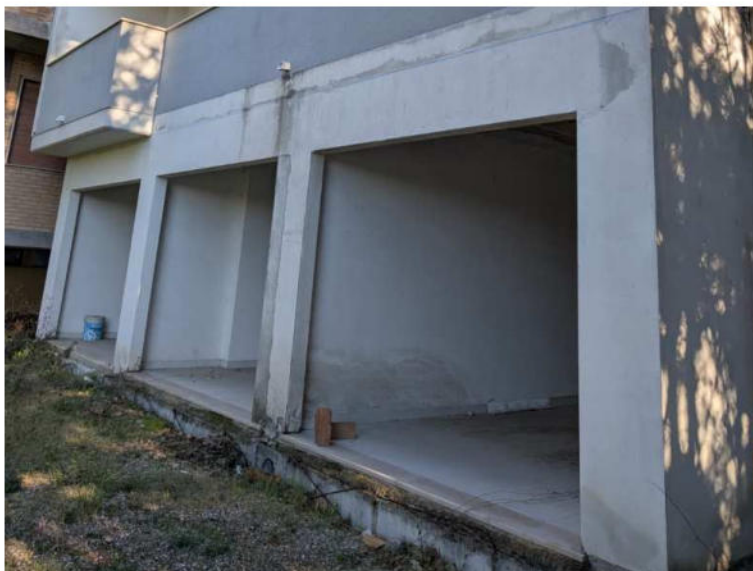
Foto n.53: ingresso garage n.ri 5, 6 e 7 (lato Sud-Ovest);
