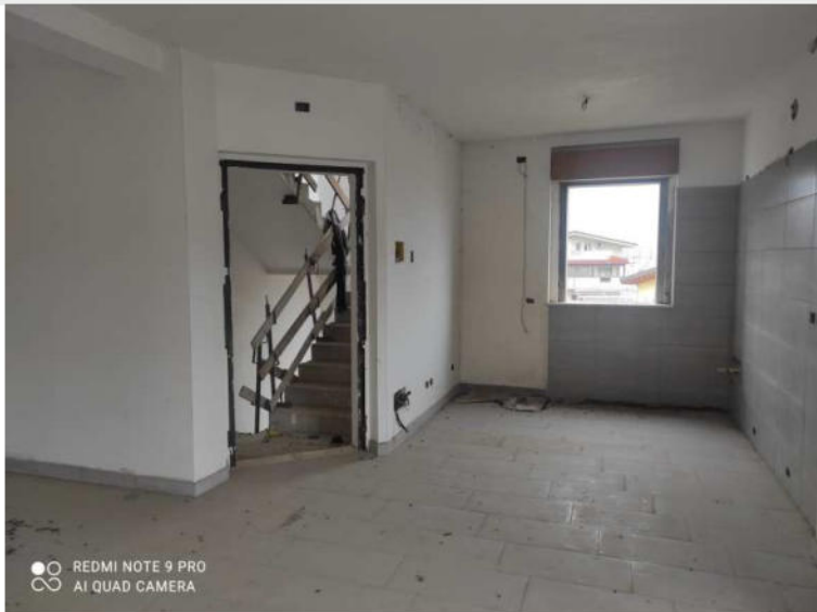
Foto n.61: veduta dell'ingresso e dell'angolo cottura dell'unità abitativa identificata con l'interno 5;
