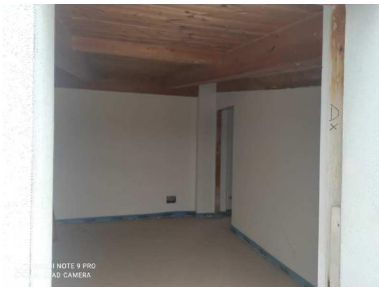
Foto n.75: veduta interna della seconda camera da letto ubicata sul lato Sud-Ovest dell'appartamento;
