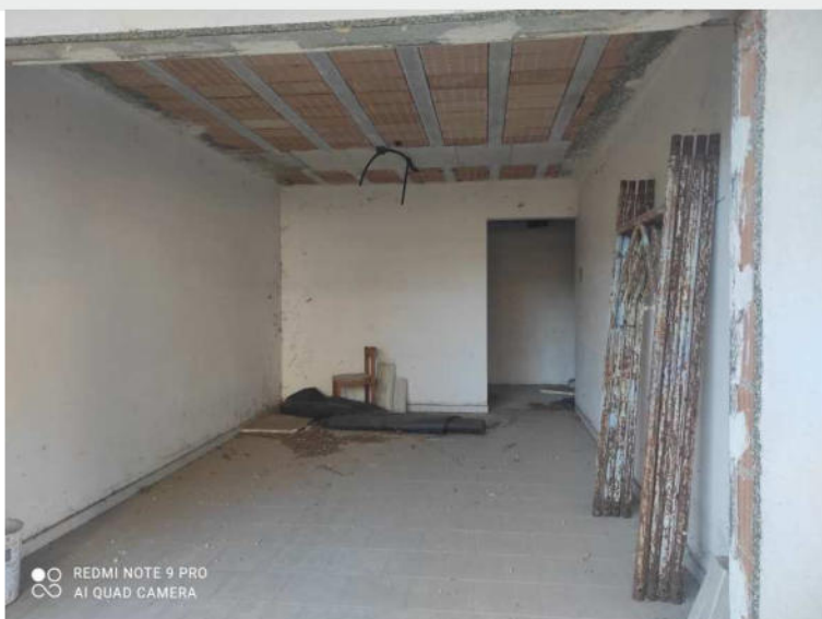
Foto n.54: veduta interna del garage n.1 di pertinenza dell'alloggio 1;
