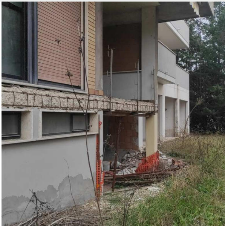
Foto n.24: demolizione del balcone ubicato lungo il lato Sud- Ovest dell'edificio;
