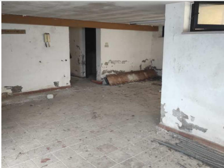
Foto n.26: veduta interna del locale accessorio, ad uso magazzino, ubicato al piano terra del villino;
