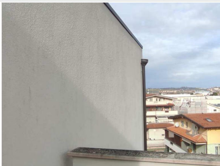
Foto n.77: balcone di pertinenza del piano sottotetto con affaccio lungo il lato Nord-Est dell'edificio;
