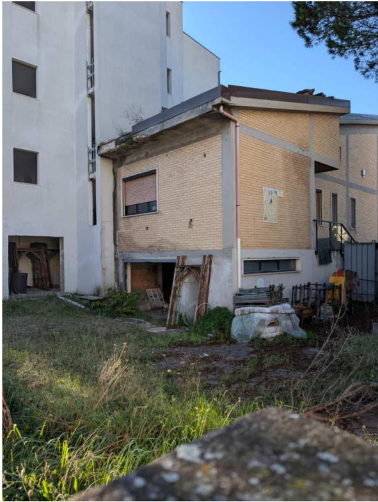
Foto n.23: prospetto lato Nord-Est (porzione di villino non demolita);
