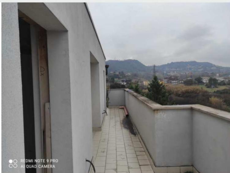
Foto n.76: balcone di pertinenza del piano sottotetto con affaccio lungo il lato Sud- Ovest dell'edificio;
