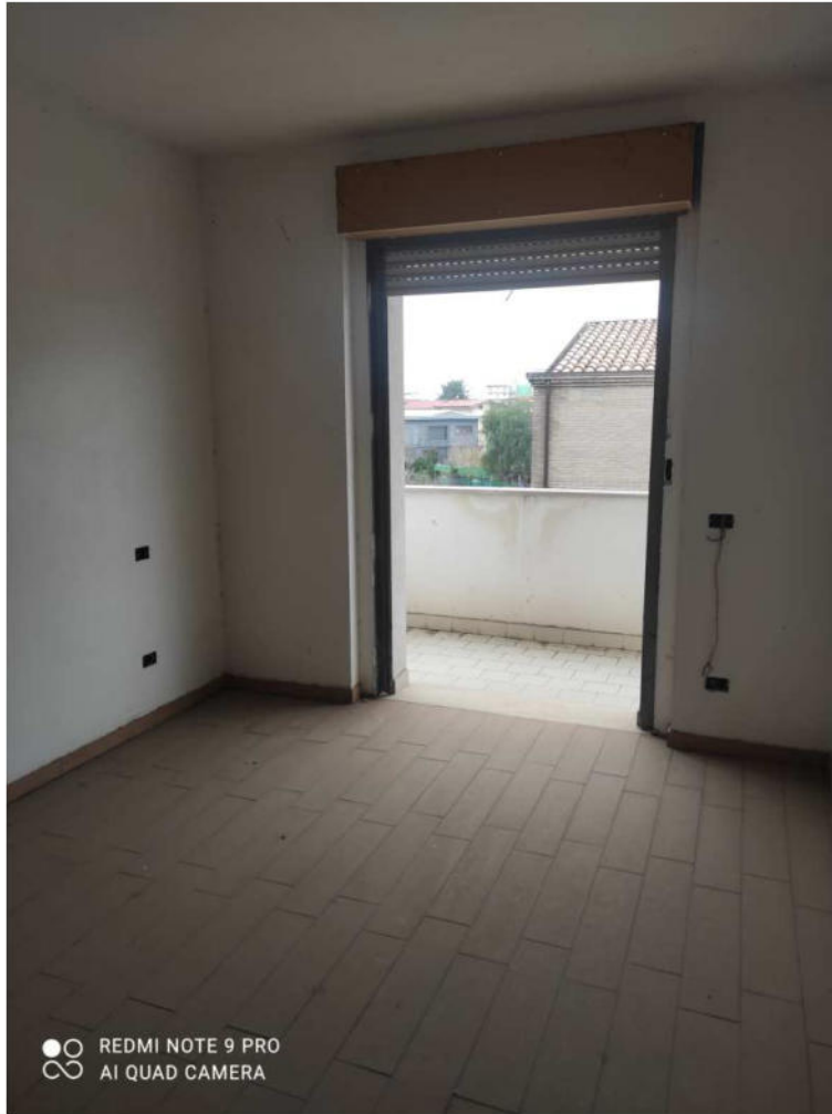
Foto n.63: veduta della camera da letto esposta a Sud-Ovest dell'unità abitativa identificata con l' interno 6;
