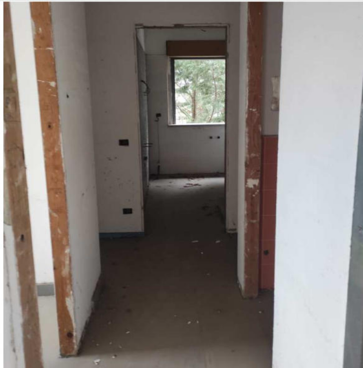
Foto n.64: veduta del disimpegno della zona notte dell'unità abitativa identificata con l'interno 1;
