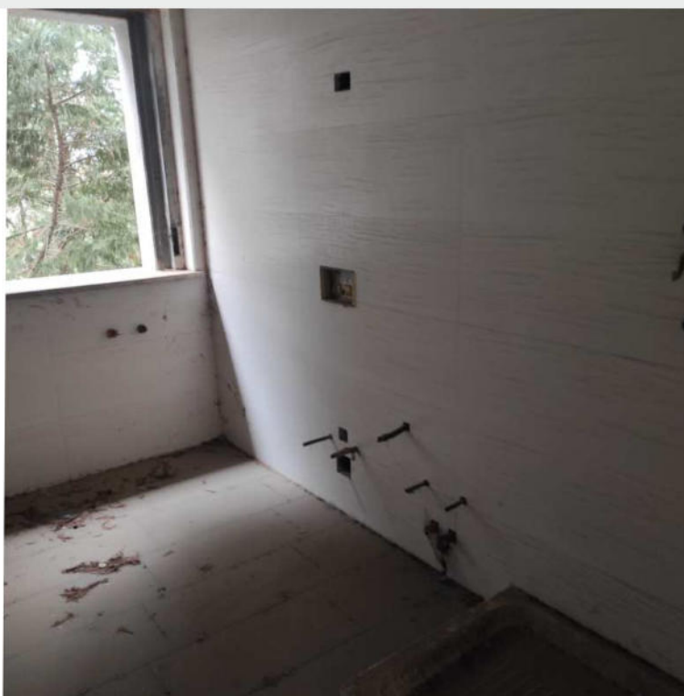
Foto n.66: particolare del rivestimento del bagno dell'unità abitativa identificata con l'interno 3;
