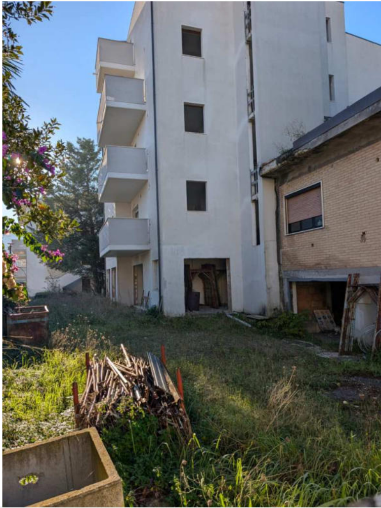
Foto n.46: veduta esterna del nuovo corpo di fabbrica della piccola palazzina;
