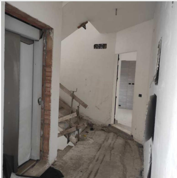
Foto n.58: pianerottolo del corpo scala caratterizzato da un taglio, a tutt'altezza, della tamponatura esterna;
