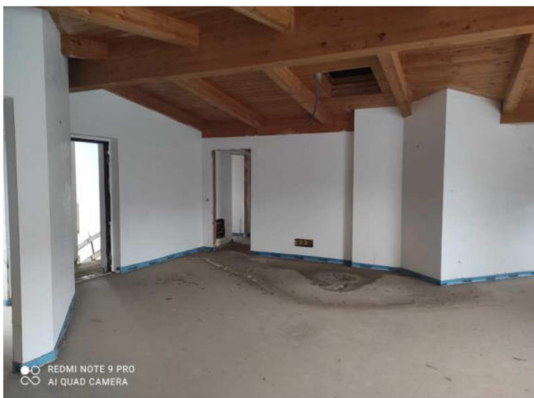
Foto n.69: vista sull'ingresso dell'unità abitativa ubicata al piano sottotetto;
