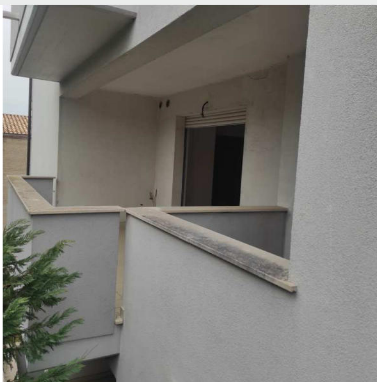
Foto n.68: particolare delle due logge di pertinenza degli interni 5 e 6;
