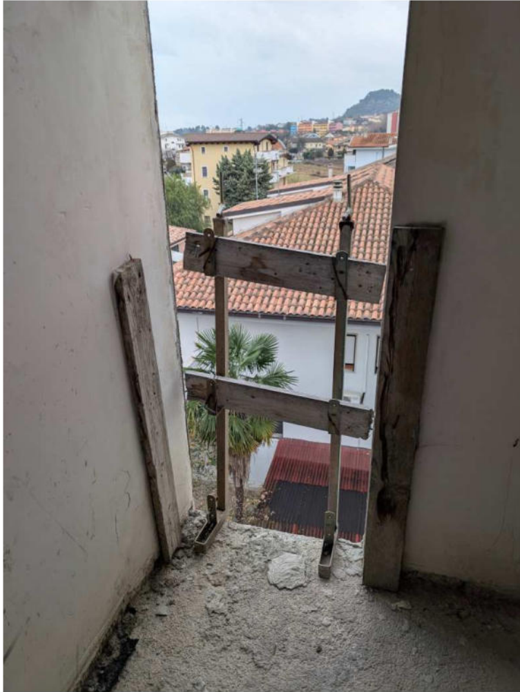
Foto n.58: pianerottolo del corpo scala caratterizzato da un taglio, a tutt'altezza, della tamponatura esterna;
