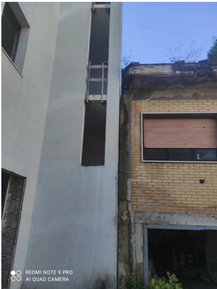
Foto n.41: porzione di villino non demolita adiacente al nuovo edificio (giunto tecnico);
