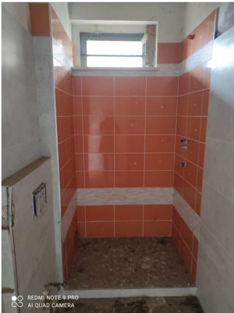
Foto n.65: particolare del rivestimento del servizio igienico dell'unità abitativa identificata con l'interno 4;
