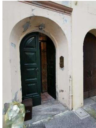
Foto 39) Part. ingresso pedonale da via XI Febbraio
