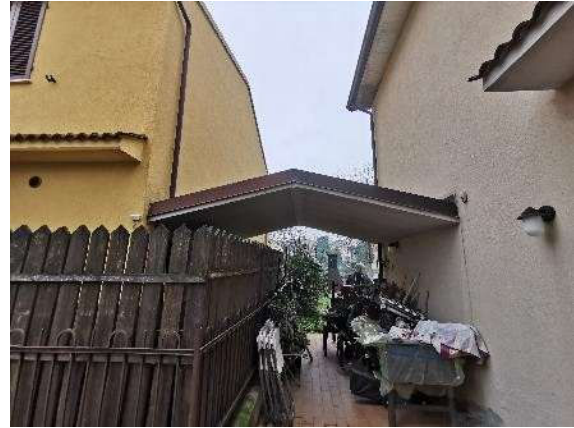
Foto 8) Part. passaggio coperto fronte posteriore
