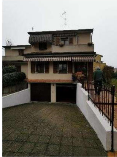
Foto 2) Part. rampa carrale di accesso al piano interrato
