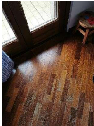
Foto 21) Part. pavimento primo piano
