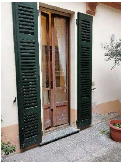
Foto 70) Part. serramento esterno
