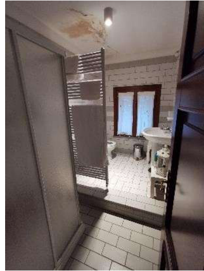
Foto 84) Part. interno – Bagno
