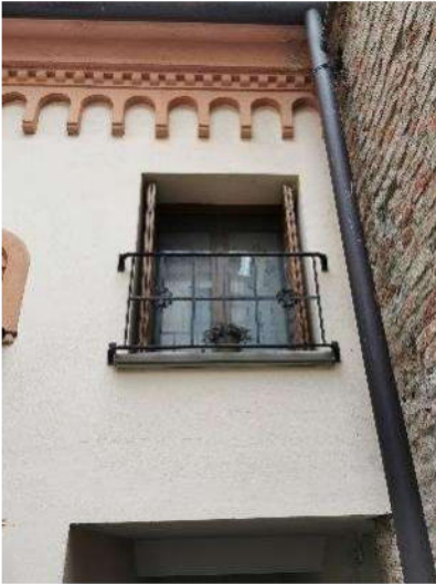
Foto 72) Part. serramento esterno
