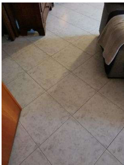
Foto 35) Part. pavimentazione interna piano terra
