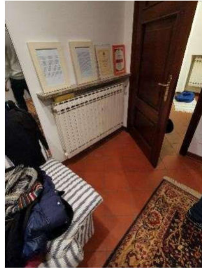
Foto 78) Part. interno pertinenza abitativa piano terra
