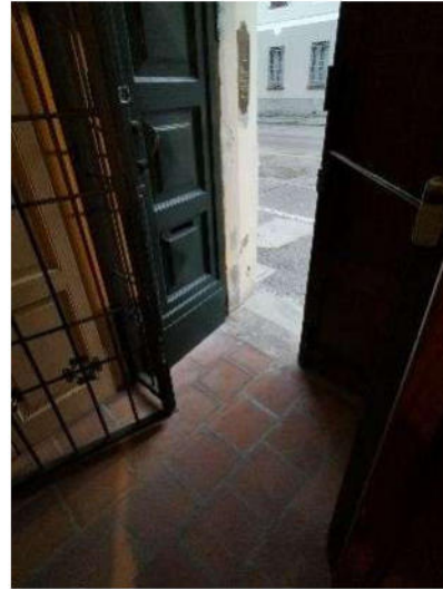
Foto 41) Part. interno portoncino ingresso da via XI Febbraio
