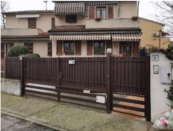
Foto 9) Part. ingresso carrale/pedonale da via Azzali
