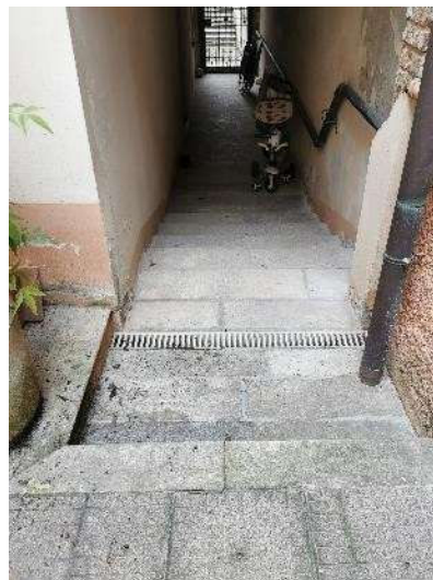
Foto 71) Part. passaggio coperto dalla corte comune
