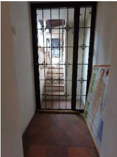
Foto 85) Part. interno – porta di uscita verso la loggia coperta
