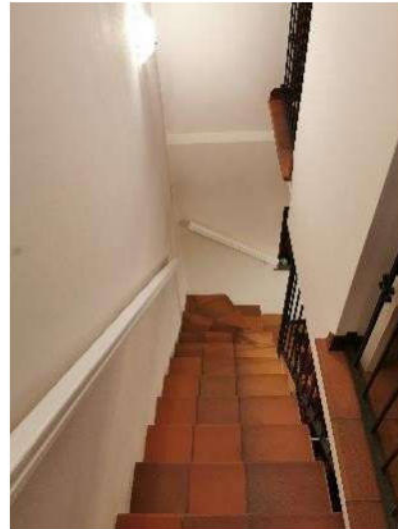
Foto 80) Part. scala interna
