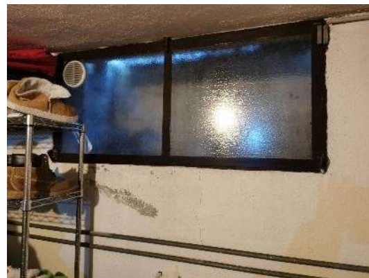
Foto 26) Part. interno – Serramento cantina
