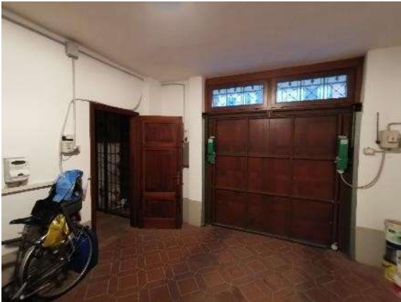
Foto 64) Vista interna autorimessa
