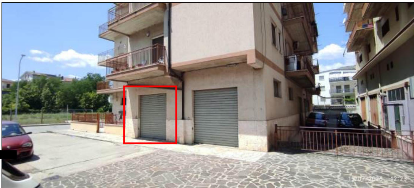
Foto 37 – Corte comune della particella 429 ed accesso al sub. 9
