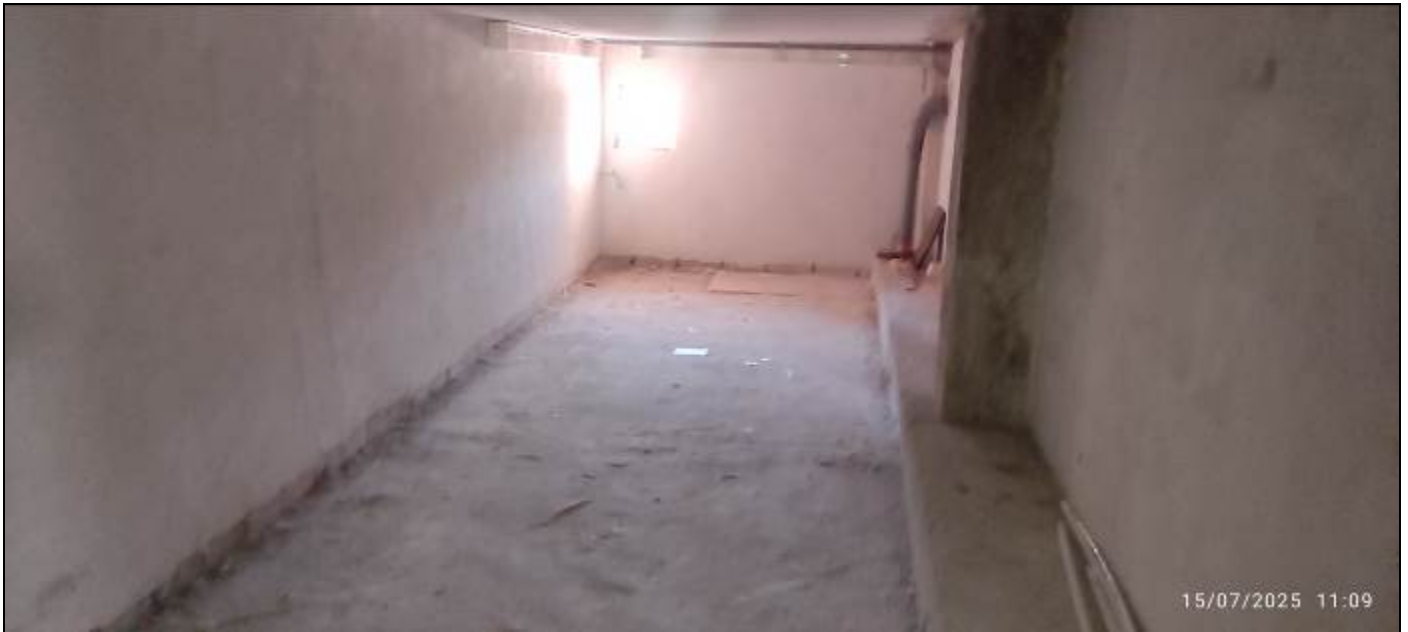
Foto 33 – Interno del sub. 143
