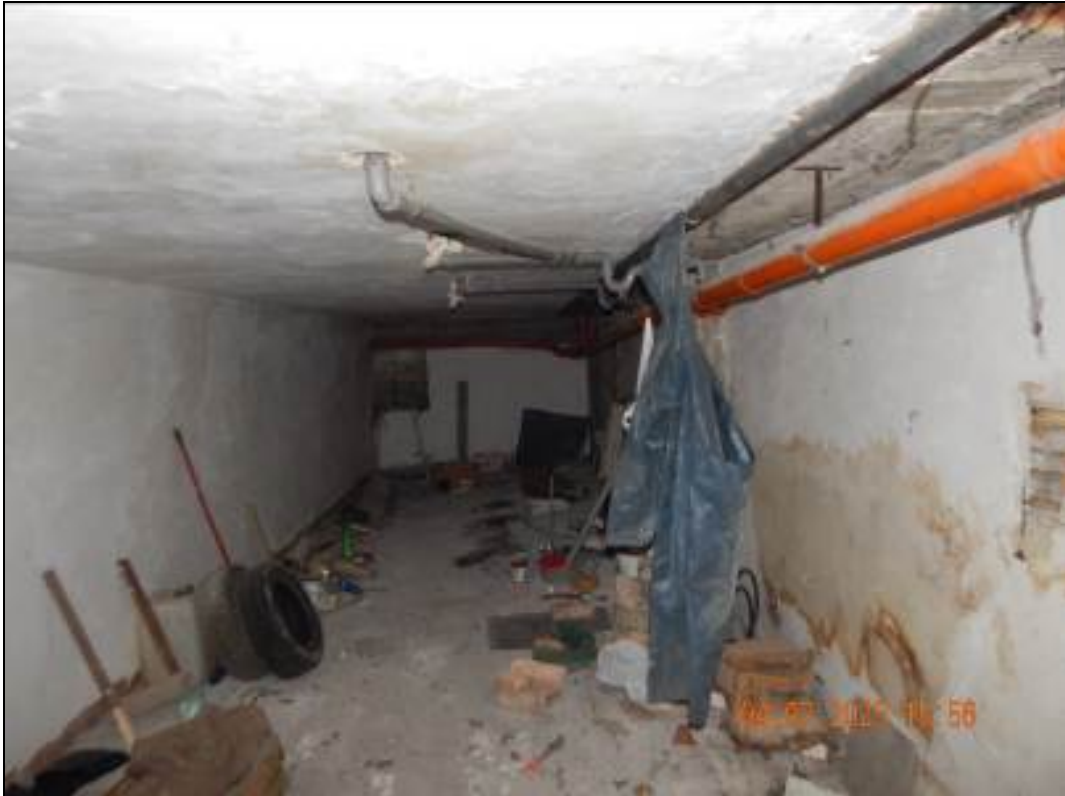
Foto 31 – Interno del sub. 141
