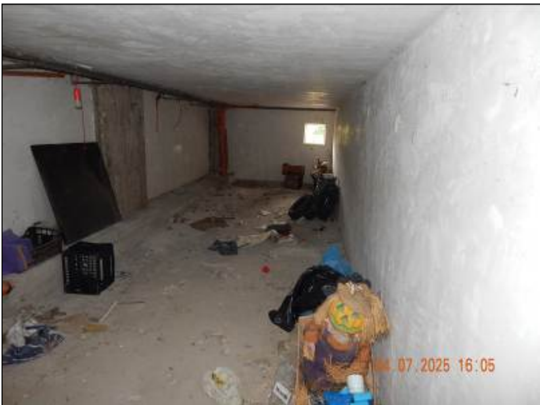
Foto 32 – Interno del sub. 142
