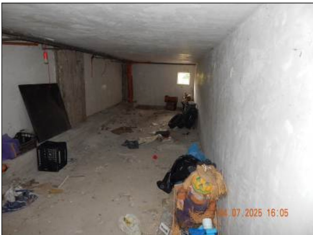
Foto 32 – Interno del sub. 142
