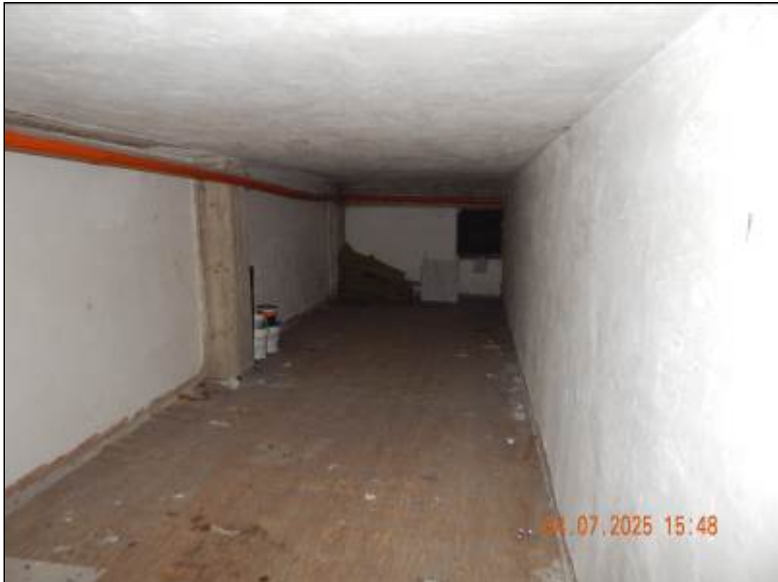
Foto 30 – Interno del sub. 140
