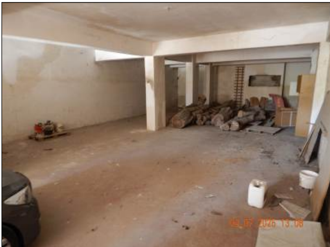
Foto 29 – Interno dei subb. 134 e 135
