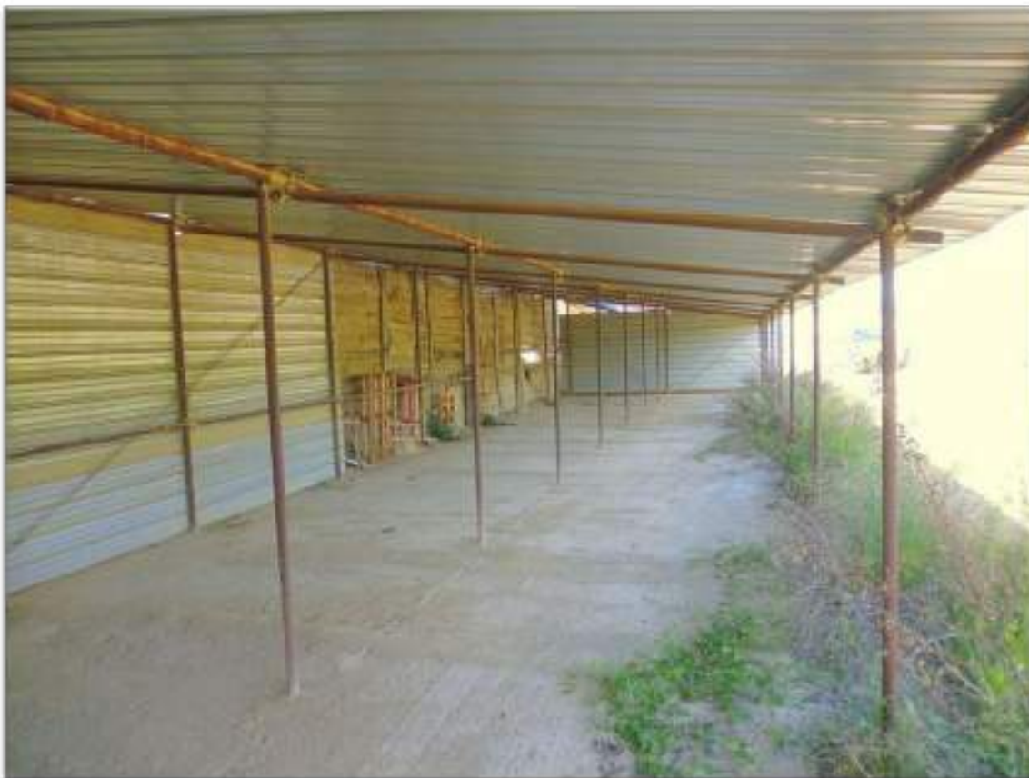
Tettoia rimessa autovetture
