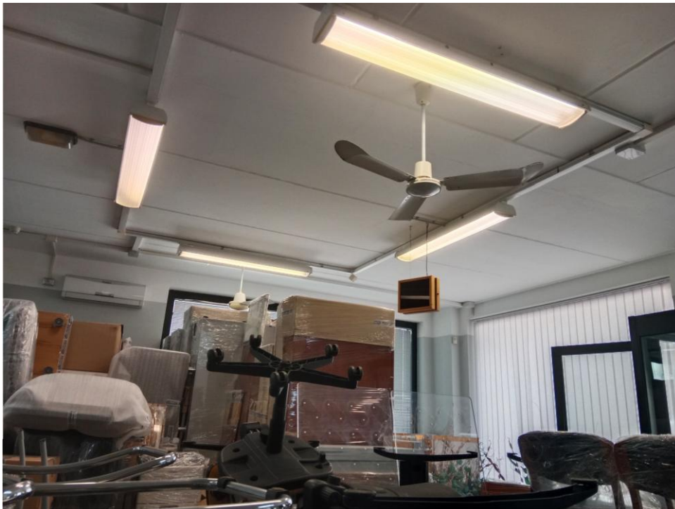
Locali Accettazione clienti Piano Terra
