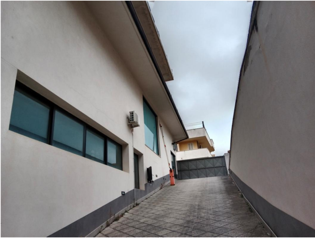
Rampa di accesso al piano seminterrato
