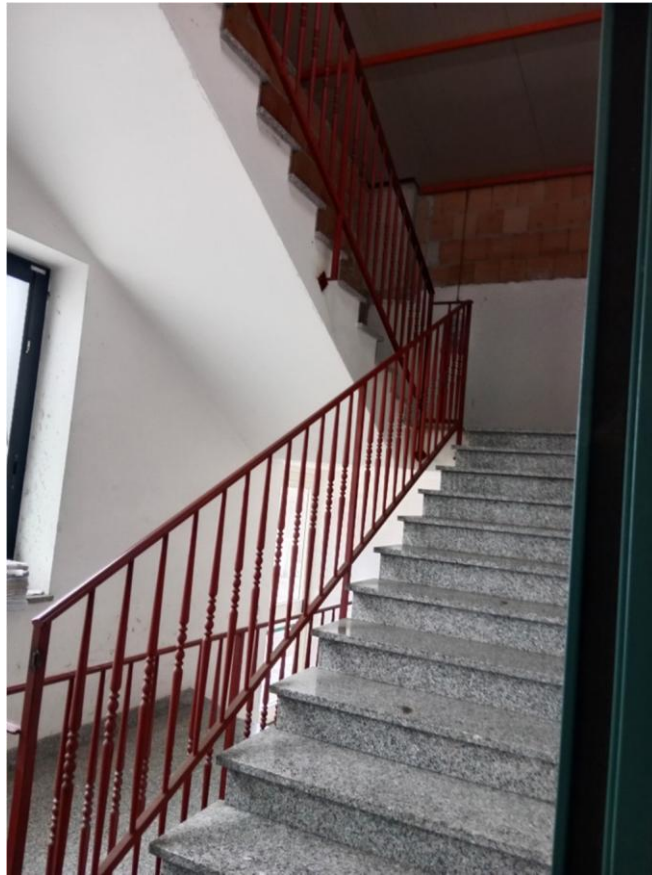
Vano scala di accesso al piano 2° (lastrico solare)
