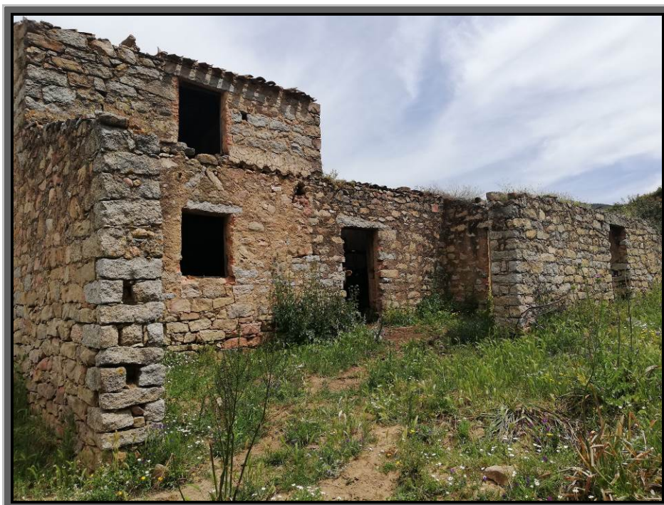
Foto 6 – Particolare fabbricato “Casa Carta” – Mappale 65 – Vista 1
