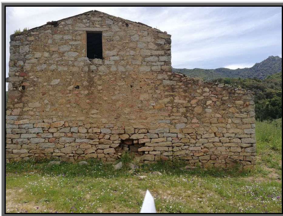
Foto 7 - Particolare fabbricato "Casa Carta" - Mappale 65 - Vista 2
