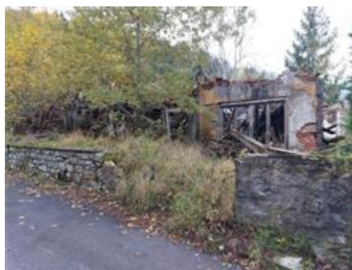
stato di fatto fabbricato - prospetto nord-est
