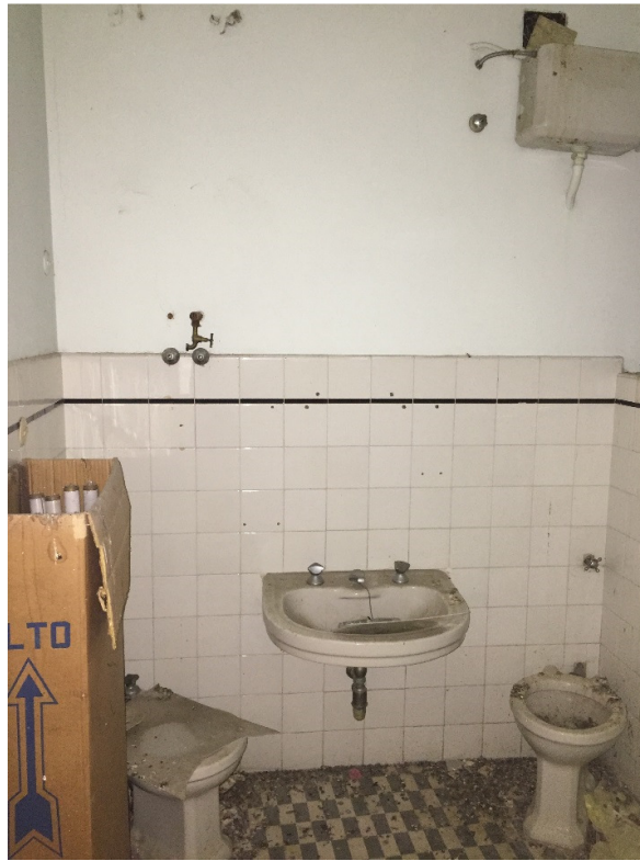
Foto 11: LOTTO B, interno
