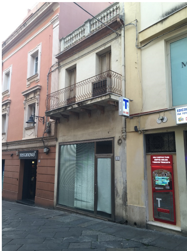
Foto 1: Esterno, C.so Garibaldi
