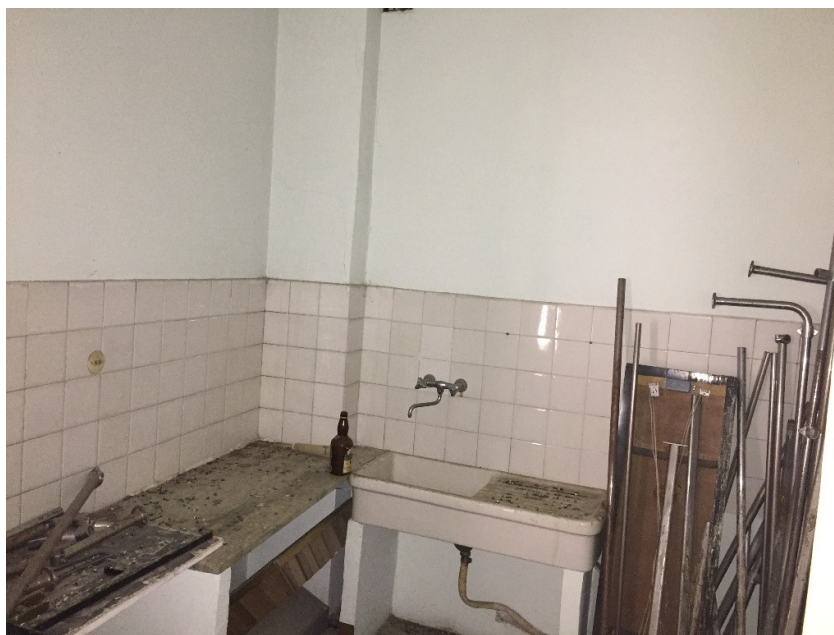
Foto 2: LOTTO A interno P.T/1°
