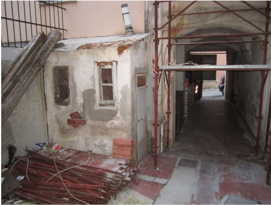
Foto 7: corridoio altra proprietà e cortile
