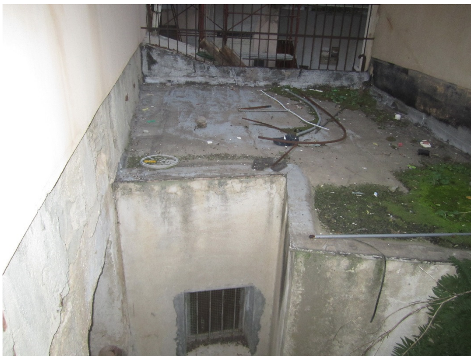
Foto 2: vista muro di confine (lato corte di pertinenza)
