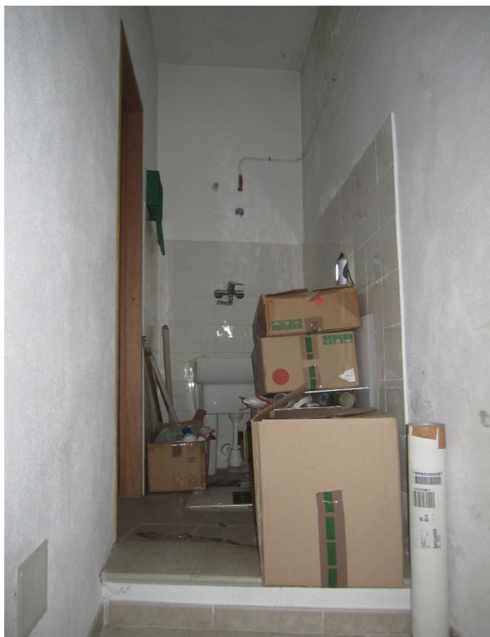
Foto 9: Ingresso al servizio igienico
