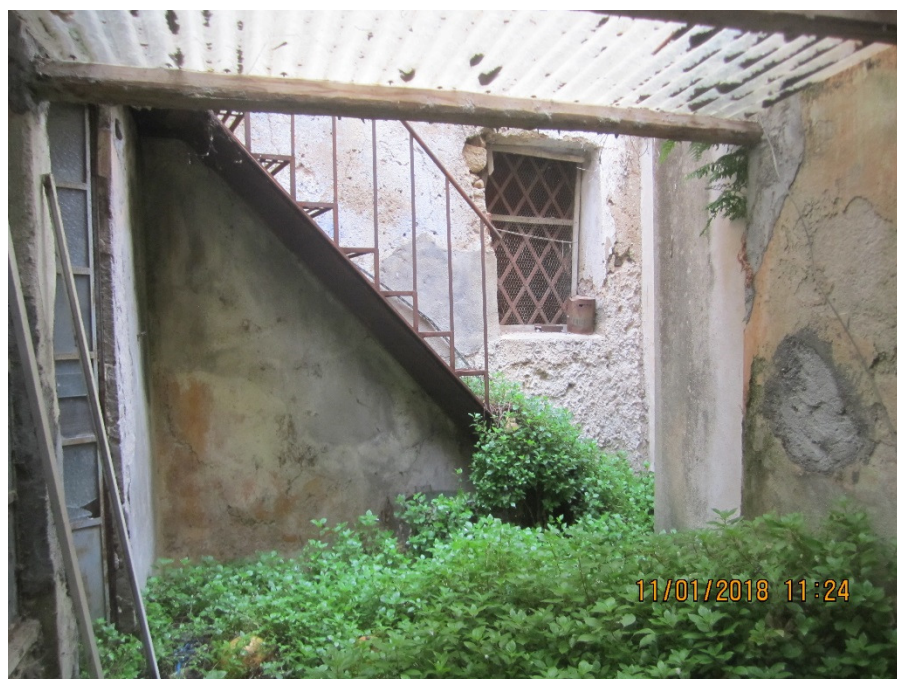
Foto 4: corte di pertinenza. Vista scala in metallo
