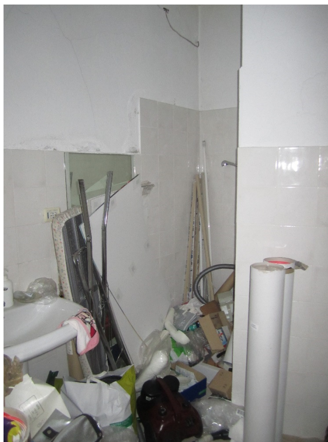
Foto 10: Ingresso al servizio igienico
