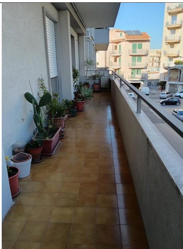
Ballatoio a servizio della zona giorno
