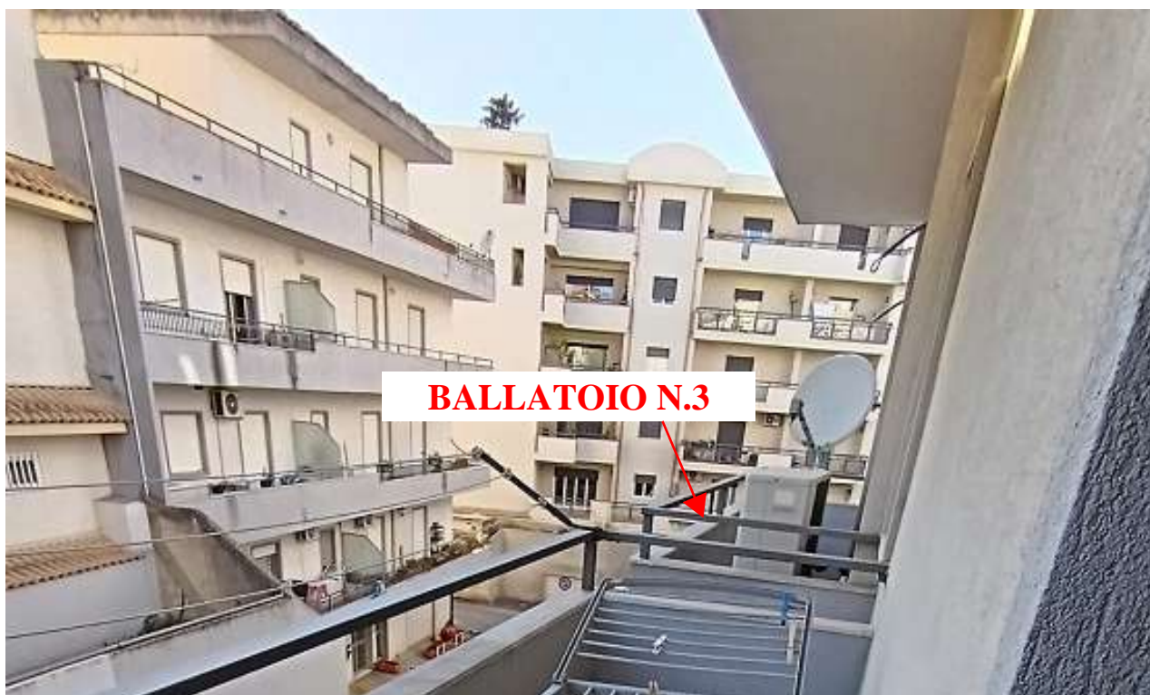
FOTO N. 18: BALLATOIO N.3 A SERVIZIO DELLA CAMERA MATRIMONIALE
