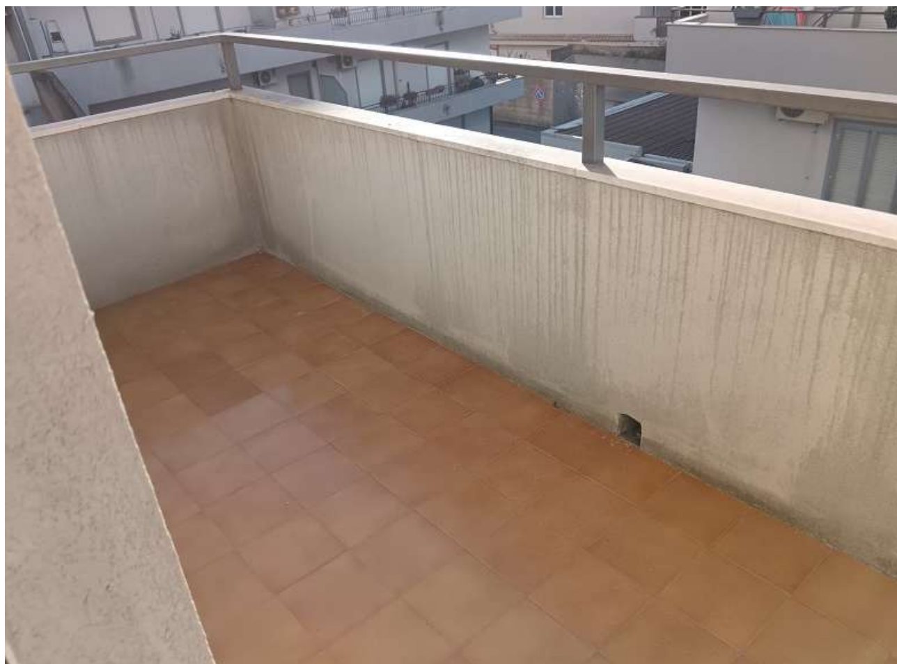
FOTO N. 19: BALLATOIO N.4 A SERVIZIO DELLA CAMERA SINGOLA
