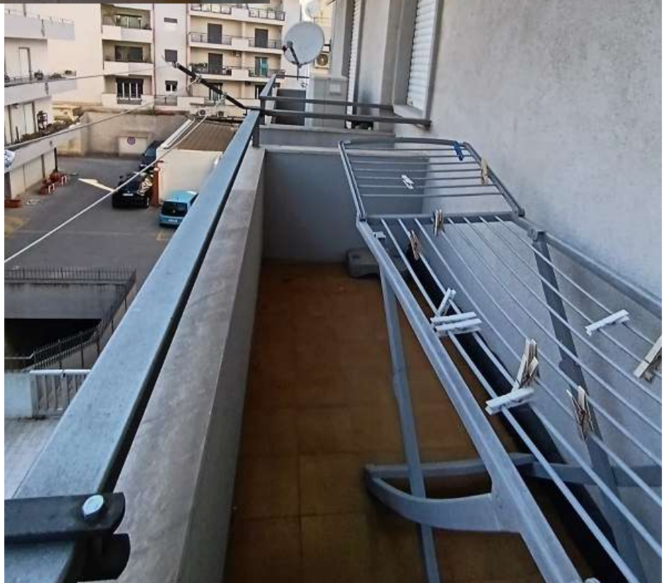
FOTO N. 17: BALLATOIO N.2 A SERVIZIO DEL RIPOSTIGLIO/LAVANDERIA
