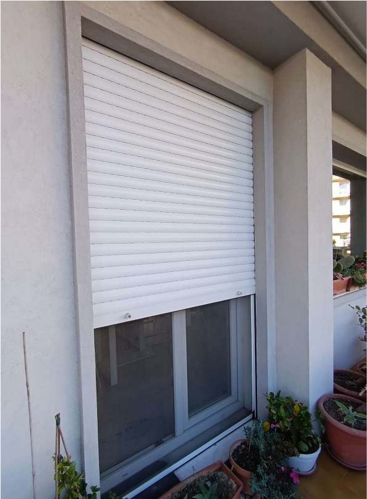
FOTO N. 20: INFISSI ESTERNI SU BALLATOIO N.1
