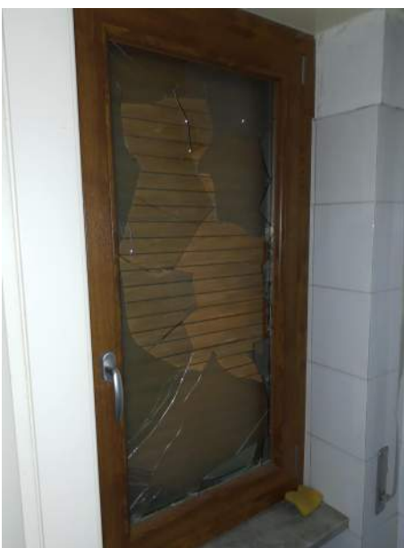
Dettaglio finestra WC
