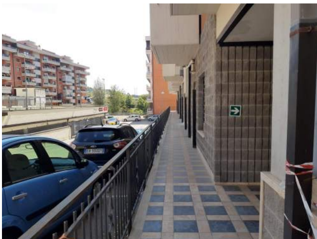
Vista del passaggio sul lato Nord
