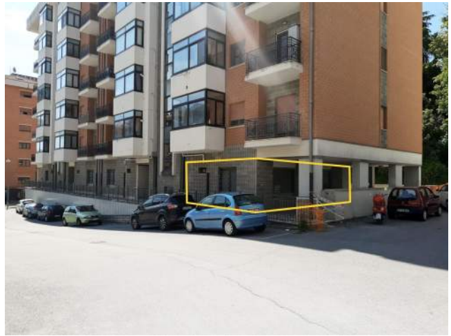
Vista del fabbricato da Nord
