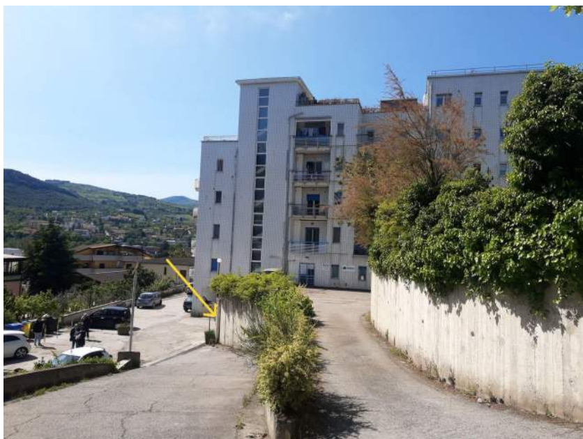
Vista della strada di accesso, del fabbricato e del piazzale di accesso ai garage
