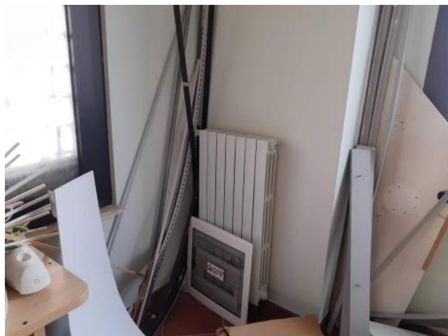
Dettaglio impianto riscaldamento
