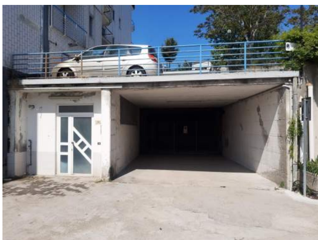
Accesso ai garage dal piazzale
