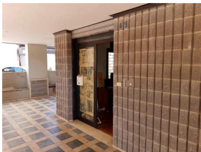
Vista dell'ingresso dal portico
