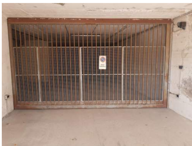
Vista della cancellata di accesso
