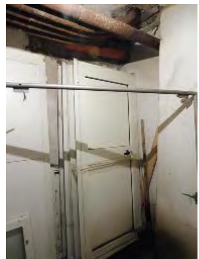
_magazzino e locale di deposito
