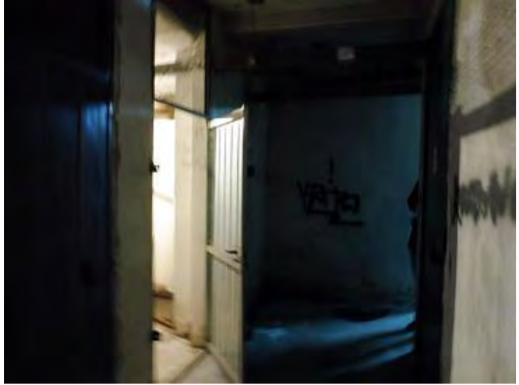
_accesso al magazzino e locale di deposito
