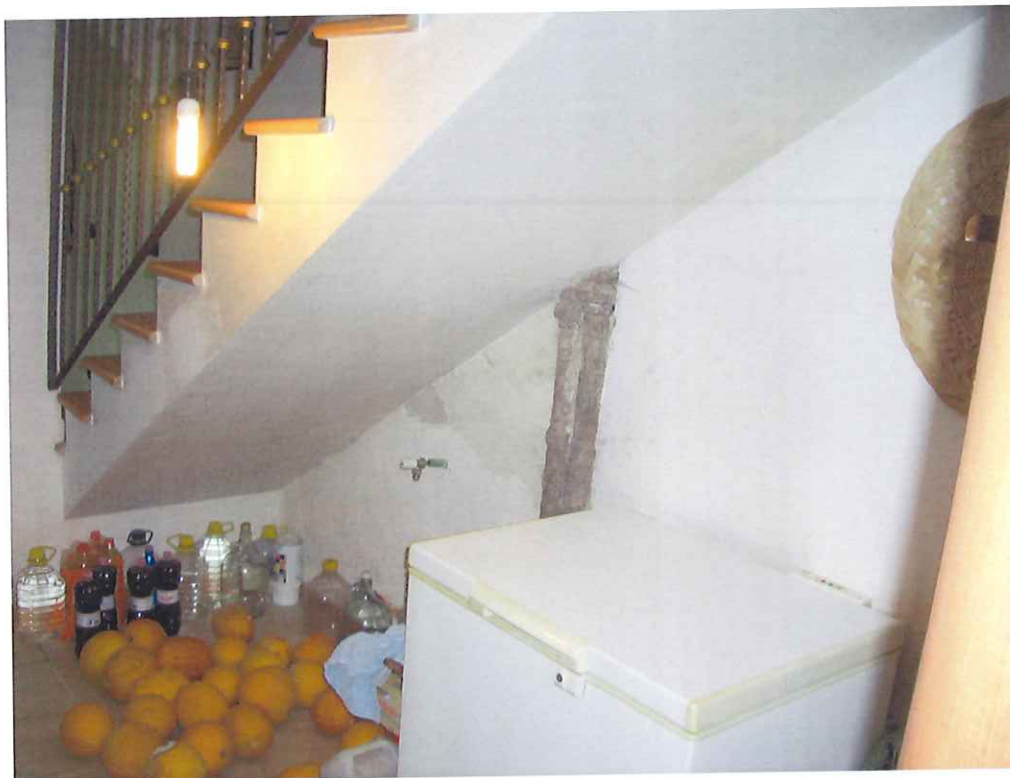
Figura 21- Sottoscala piano interrato.
