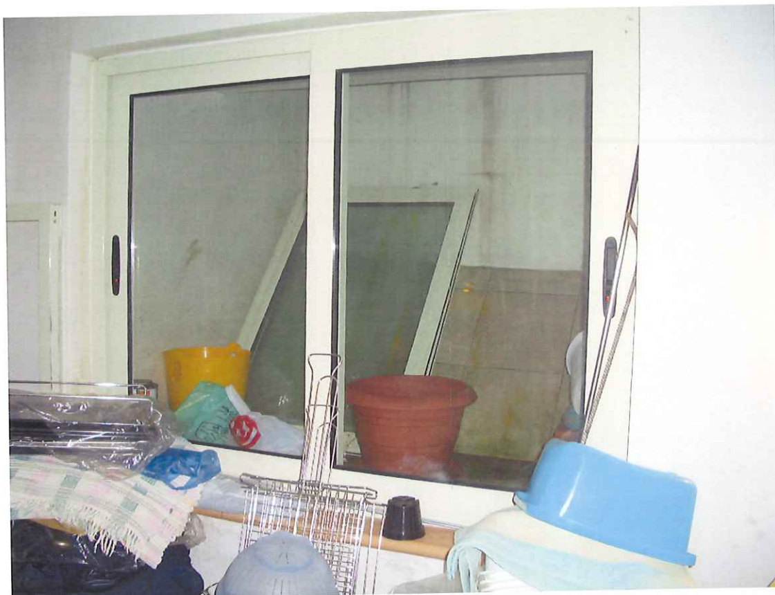
Figura 31- Aperture chiuse destinate all'areazione del locale interrato.
