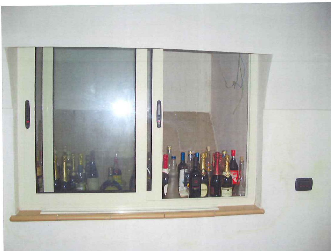
Figura 33- Aperture chiuse destinate all'areazione del locale interrato.
