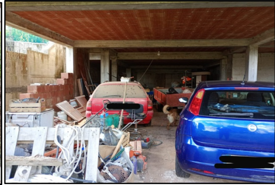
Foto_15 Struttura a rustico seminterrato
