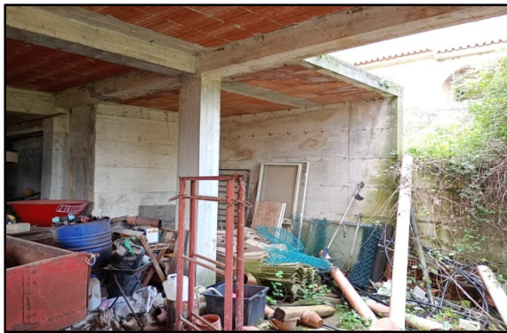
Foto_14 Struttura a rustico seminterrato
