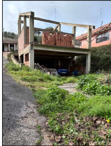
Foto_13 Struttura a rustico
