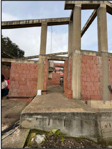
Foto_12 Struttura a rustico
