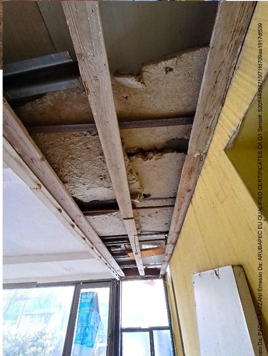
PARTICOLARE DELLA COPERTURA DELLA VERANDA A CONTATTO CON L'EDIFICIO
