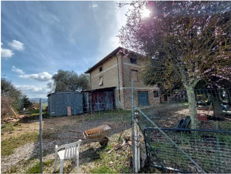
Foto edifici a Nord della proprietà (allegati A,B,C,D)
