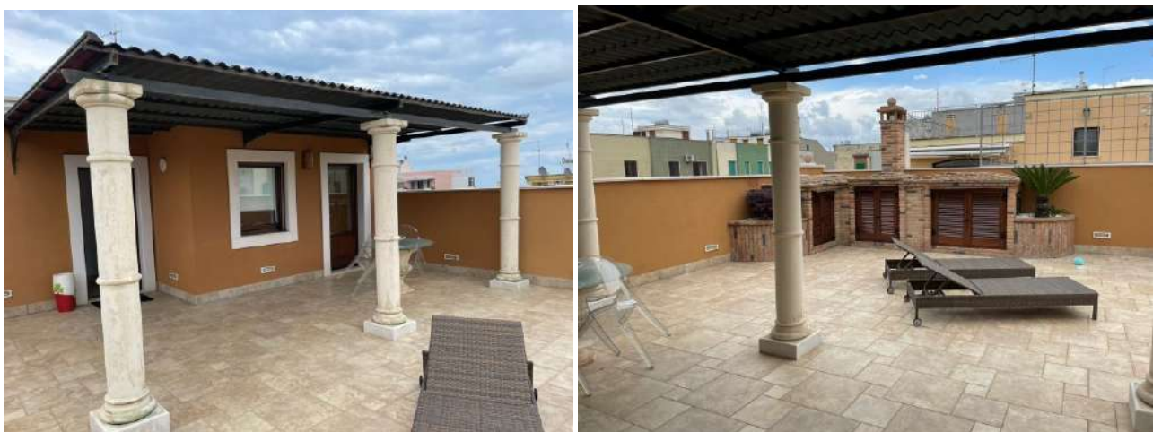
Lastrico solare a Piano Secondo
