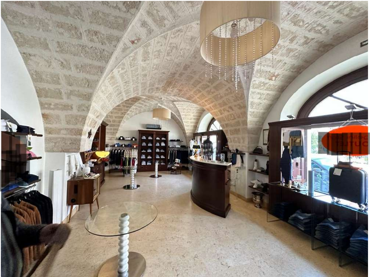
FOTO INTERNE DEL PIANO TERRA ATTIVITA' COMMERCIALE
