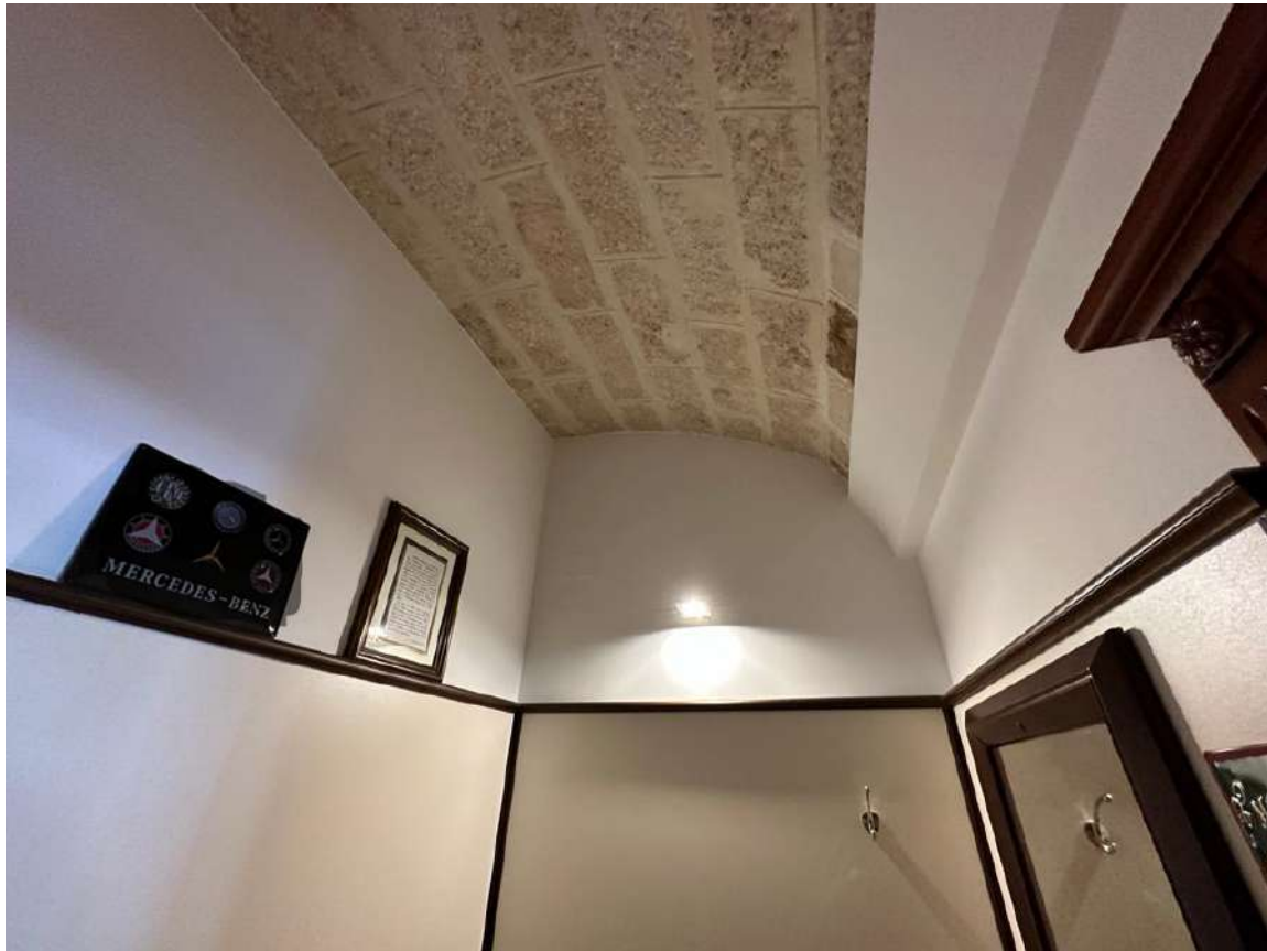
FOTO INTERNE DEL PIANO TERRA ATTIVITA' COMMERCIALE
