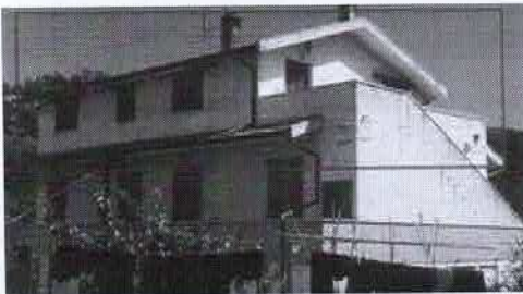
Prospetto ovest e scala di accesso scoperta
