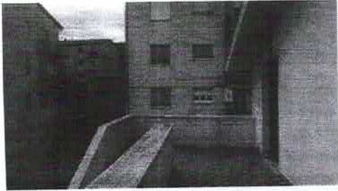
Zona ingresso al piano mansarda con terrazzo
