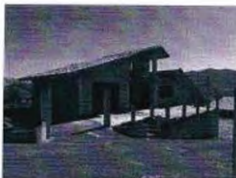
Fabbricato di cui al corpo "D"
