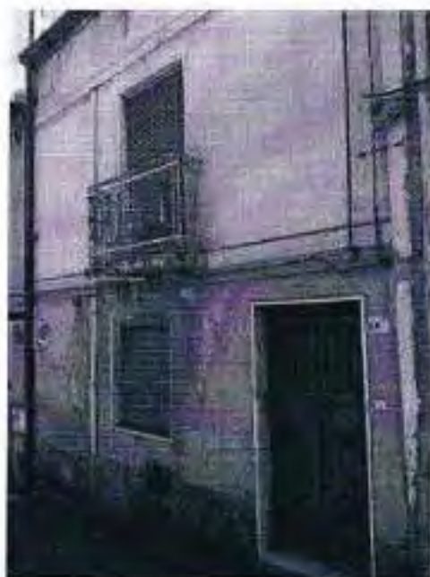
Prospetto del fabbricato da via Gebbia
