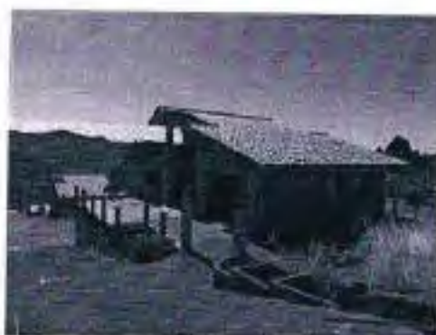
Fabbricato di cui al corpo "C"
