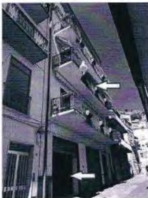
Prospetto principale del fabbricato (con indicazione del corpo G)
