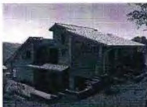
Fabbricato denominato corpo "E"
