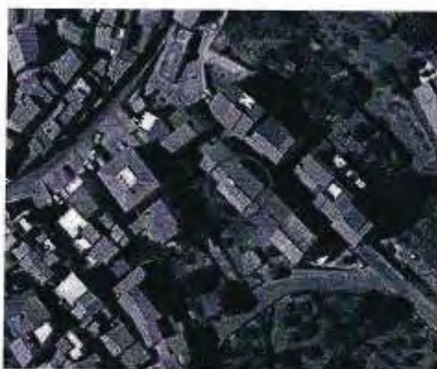
foto aerea della zona in cui ricade il fabbricato
