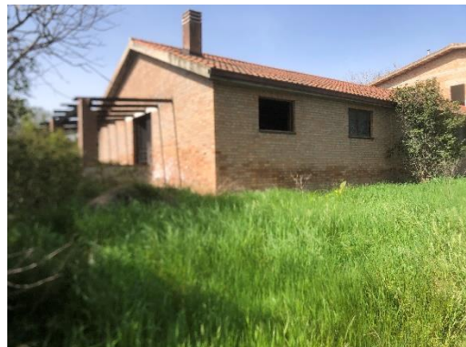
EX DEPOSITO-FORESTERIA DA S-E
