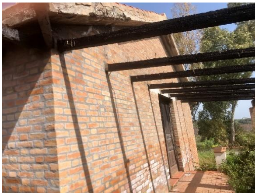
TETTOIA PERCORSO DA INCENDIO
