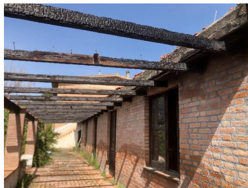
TETTOIA PERCORSO DA INCENDIO
