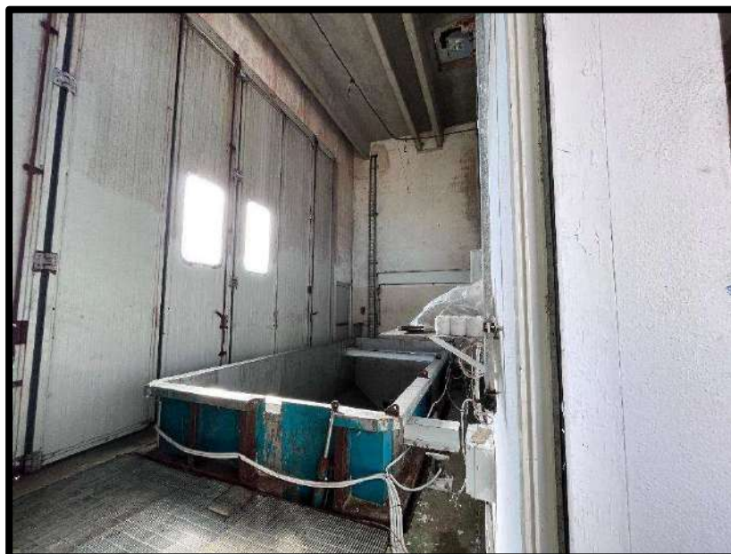
Foto 22 - Tramoggia di carico
