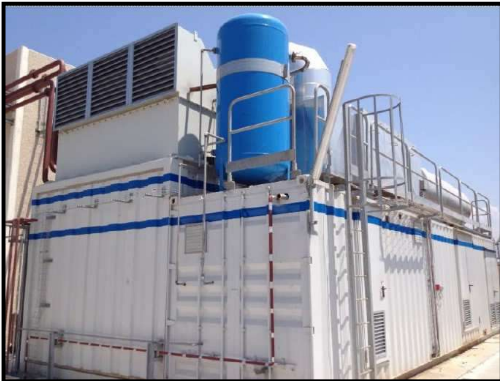
Foto 15 - Scala accesso copertura container cogeneratore
