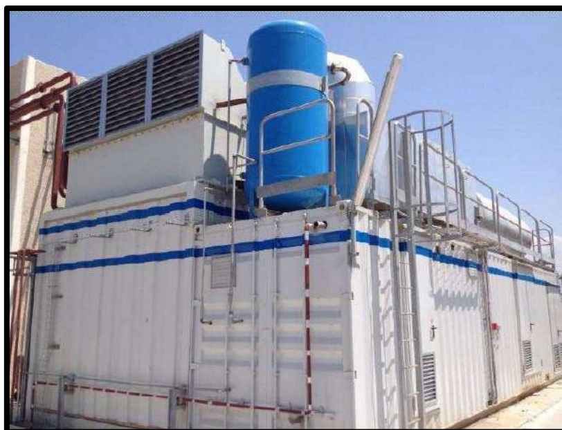
Foto 15 – Scala accesso copertura container cogeneratore
