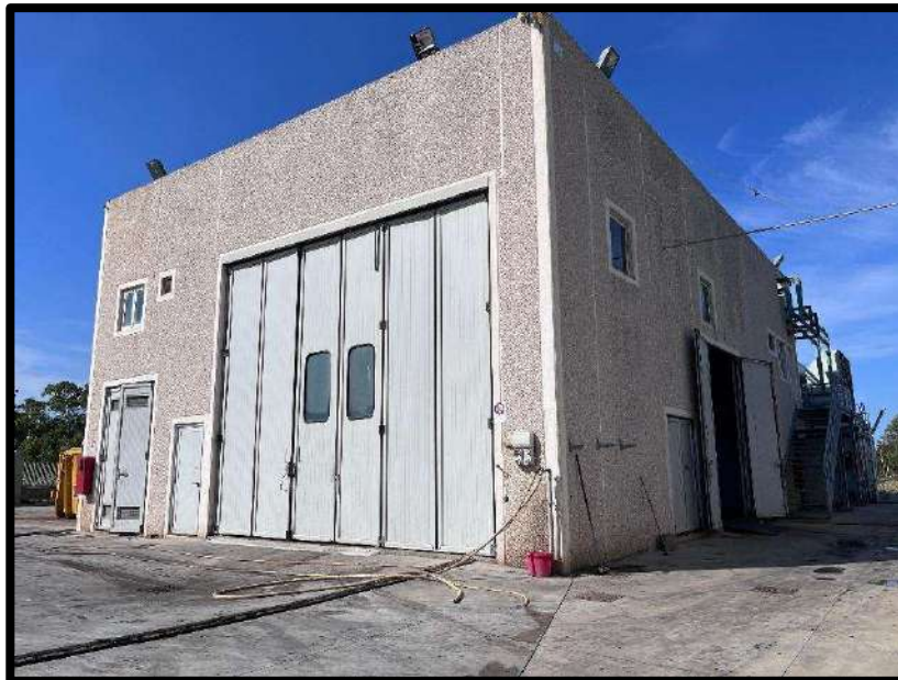
Foto 20 - Prospetto nord -est capannone
