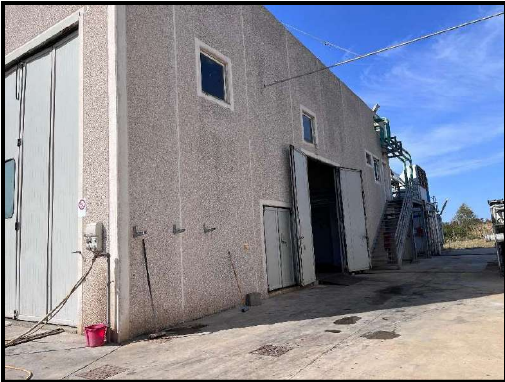
Foto 21 - Prospetto nord - ovest capannone
