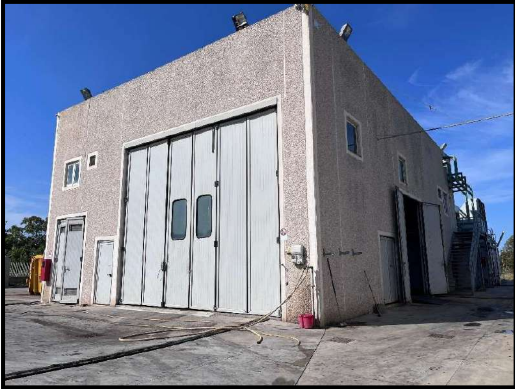
Foto 20 - Prospetto nord -est capannone
