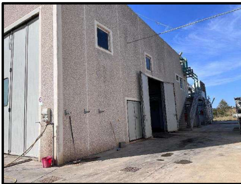
Foto 21 - Prospetto nord - ovest capannone
