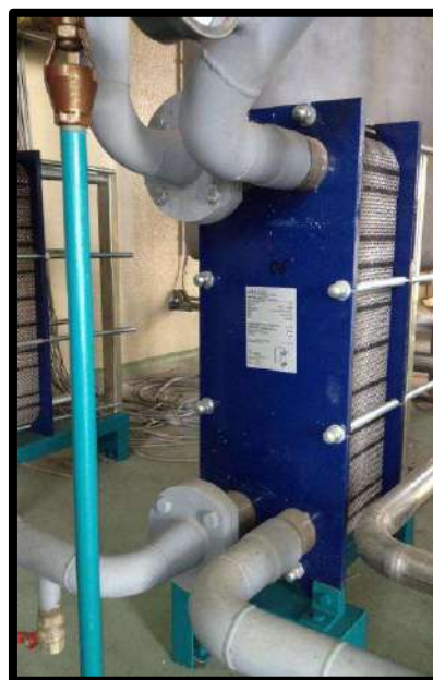
Foto 9 - Scambiatore a piastre recupero HT
