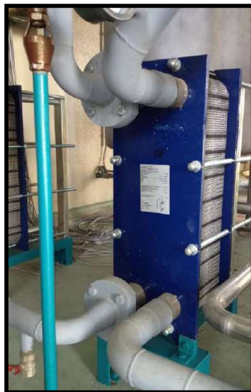
Foto 9 - Scambiatore a piastre recuperato HT
