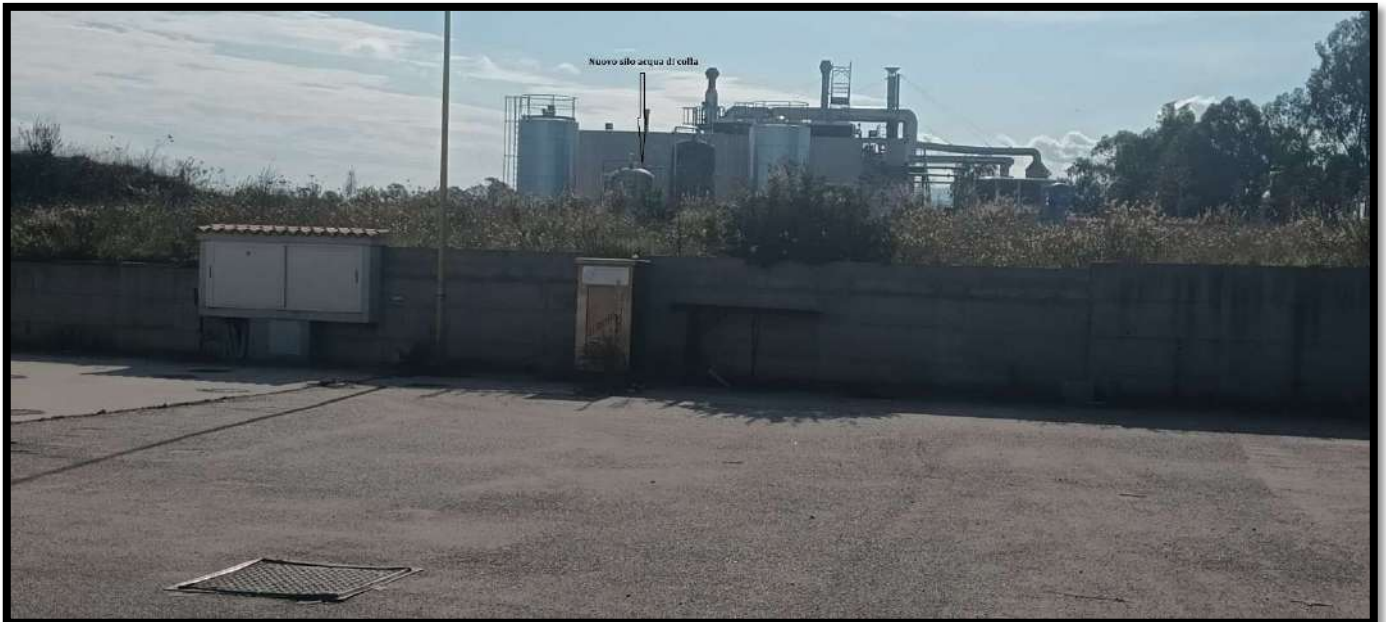
Foto 19 - Silos olio combustibile ed acqua di colla (nuovo)
