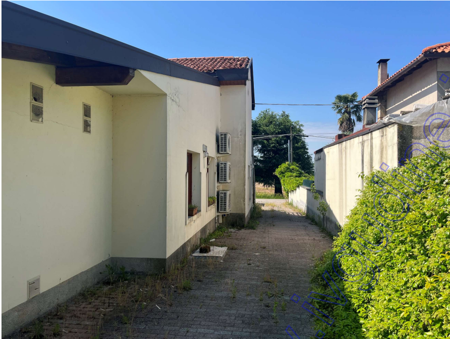
FOTO3: ALTRA VISTA DEL FABBRICATO
