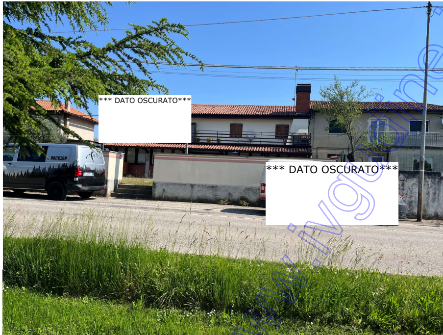
FOTO 1: FACCIATA PRINCIPALE FABBRICATO
