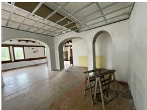
Piano terra sala ristorante e bar.
