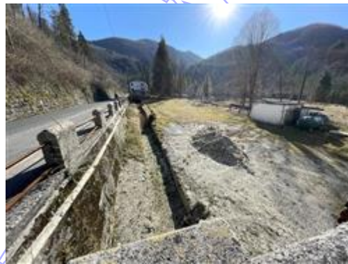
Vista area esterna mappali 166-167 e canali.
