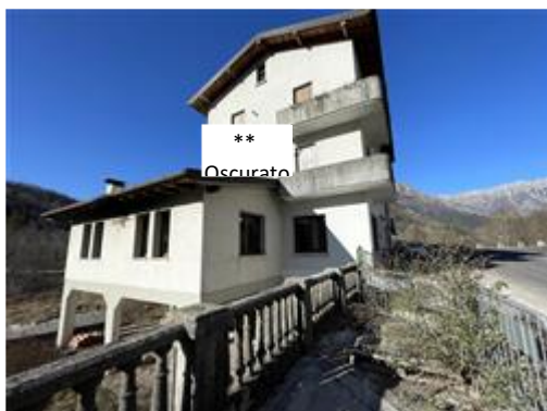
Prospetto a sud.
