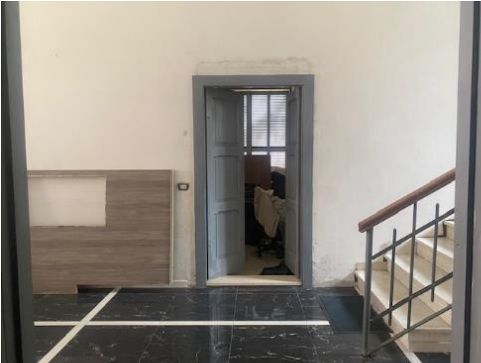
INGRESSO MAGAZZINO PIANO TERRA
