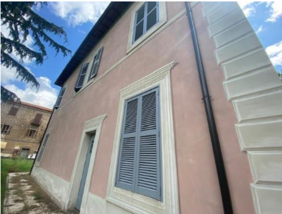
FACCIATA SUL GIARDINO
