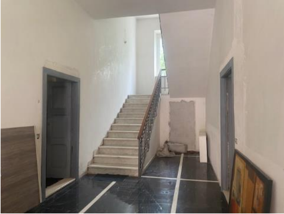
INGRESSO PIANO TERRA
