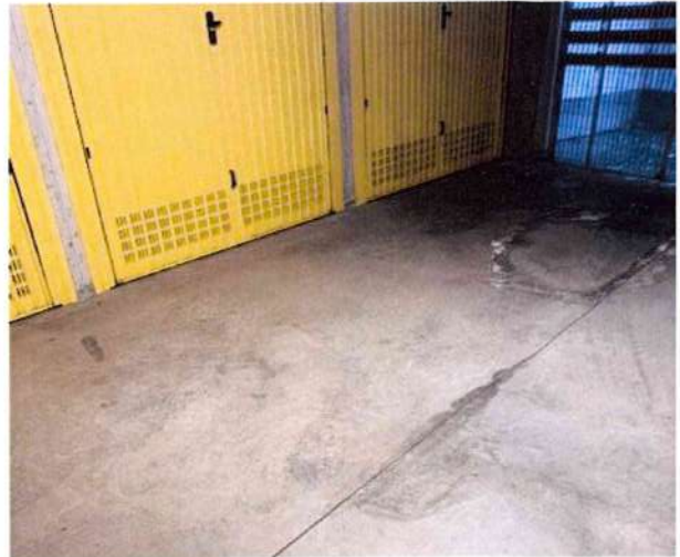
Area di manovra
