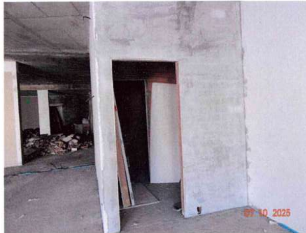
Ingresso anti bagno e wc
