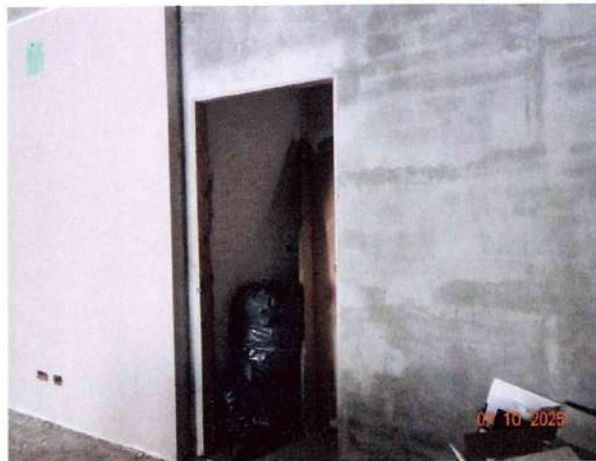
Ingresso anti bagno e wc
