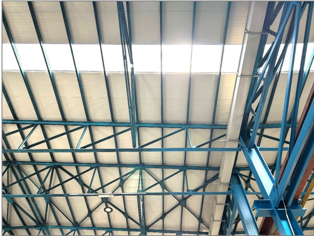
Figura 3: Intradosso della copertura
