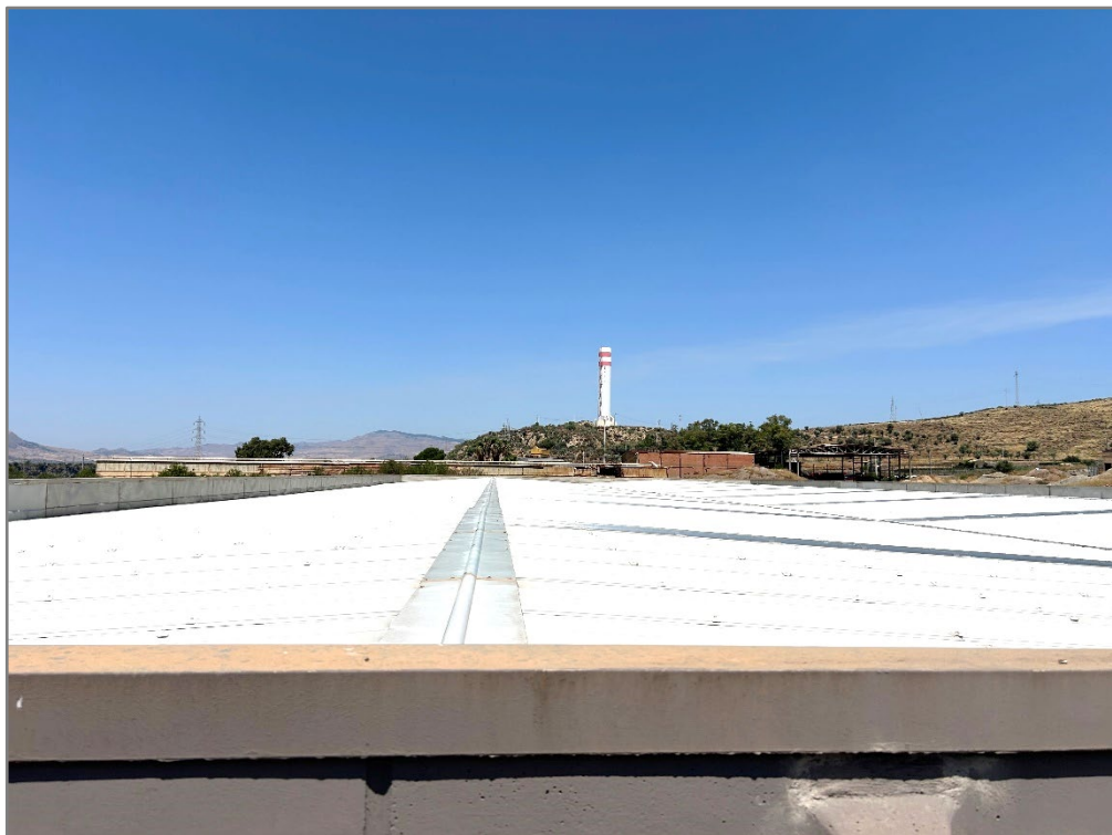
Figura 4: Estradosso della copertura - Lastrico solare
