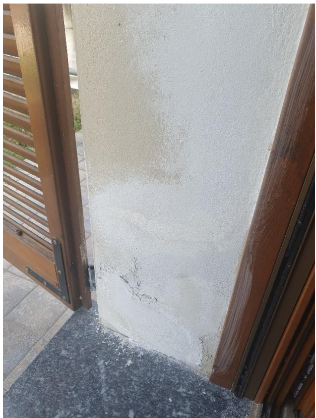
FOTOGRAFIE 49-50: particolare di una portafinestra, con macchie di umidità parzialmente risanate sul muro.
