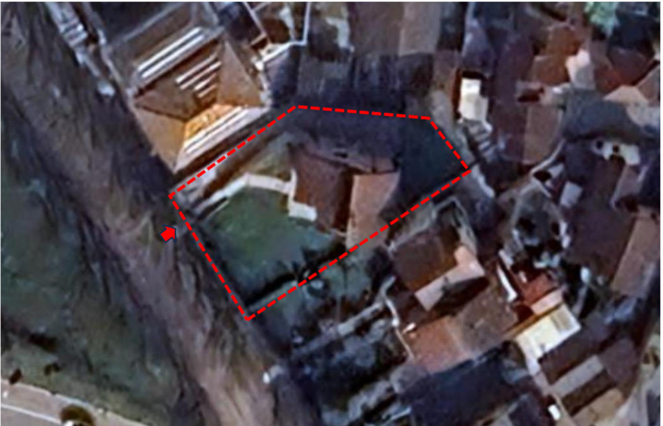
INQUADRAMENTO AEREO: Vista d'insieme del lotto e del fabbricato, contornati in rosso.
