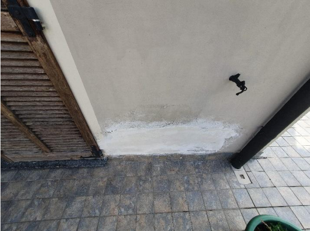
FOTOGRAFIE 53-54: particolari del muro esterno con segni di deterioramento, in alcuni punti parzialmente sistemato.
