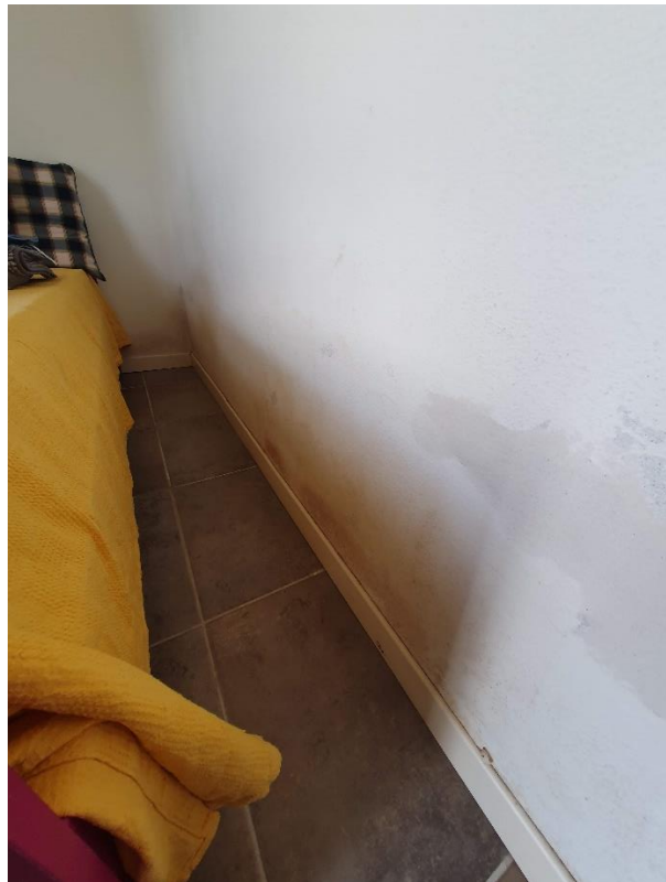
FOTOGRAFIE 19-20: Viste della camera a piano terra, con macchie di umidità sul muro.
