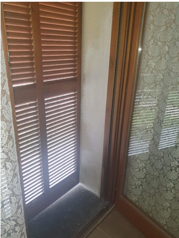
FOTOGRAFIE 49-50: particolare di una portafinestra, con macchie di umidità parzialmente risanate sul muro.
