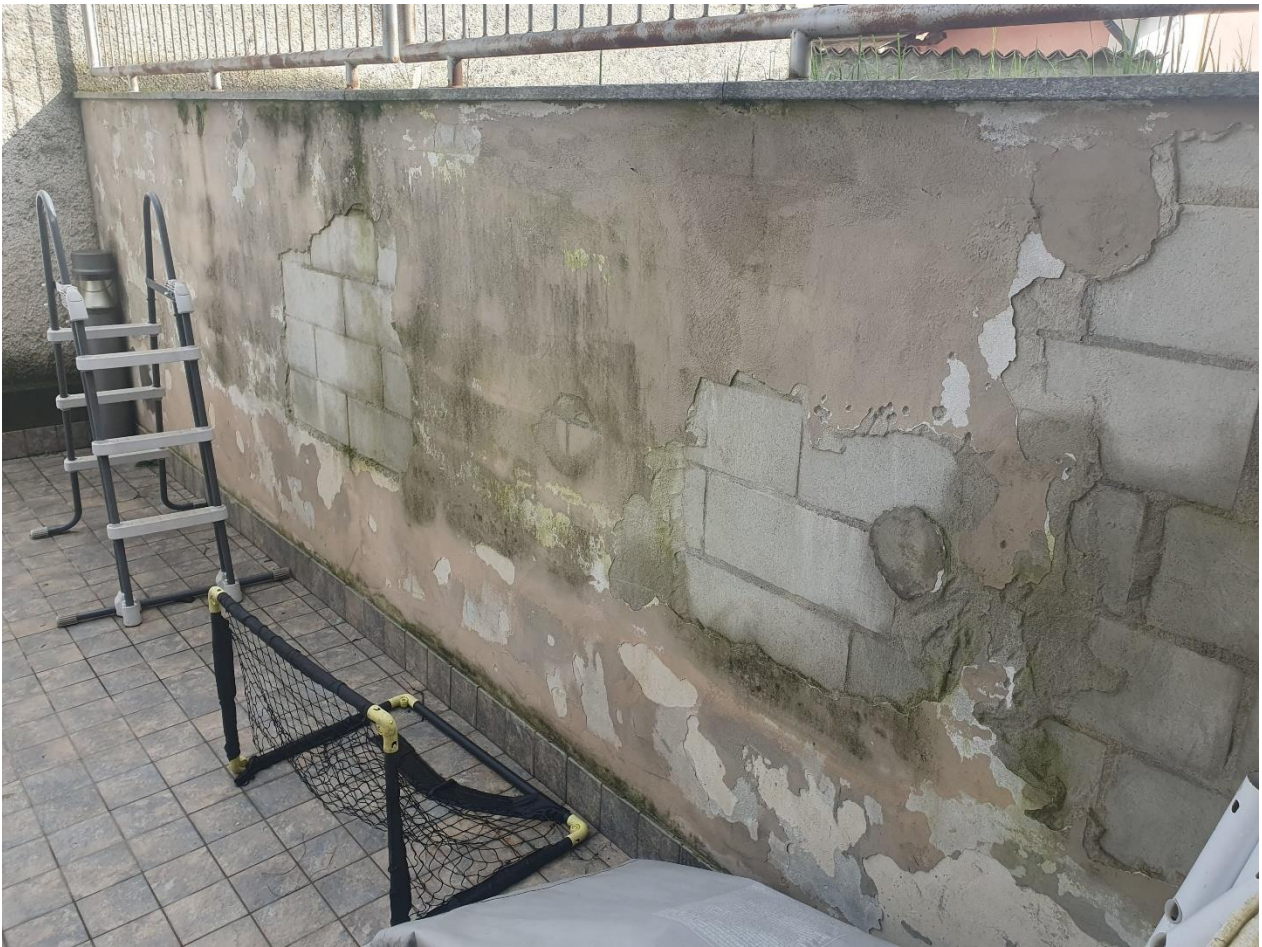
FOTOGRAFIA 55: muro di sostegno del giardino.
