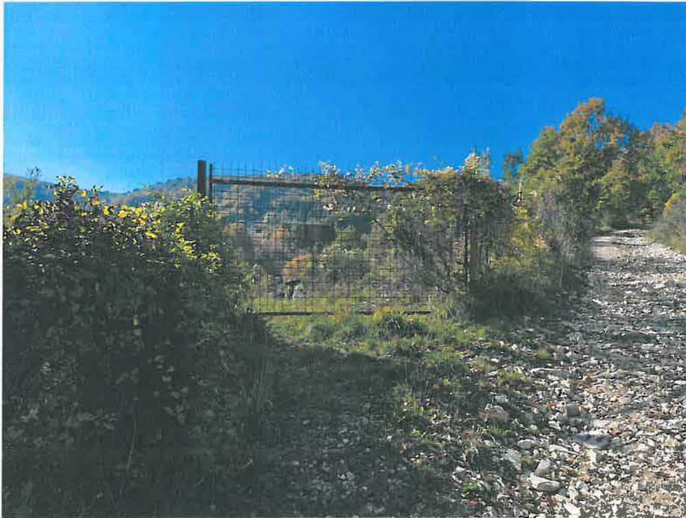
Foto nr. 4 – Vista Ingresso alla p.lla 538 -539 – 568 - 569
